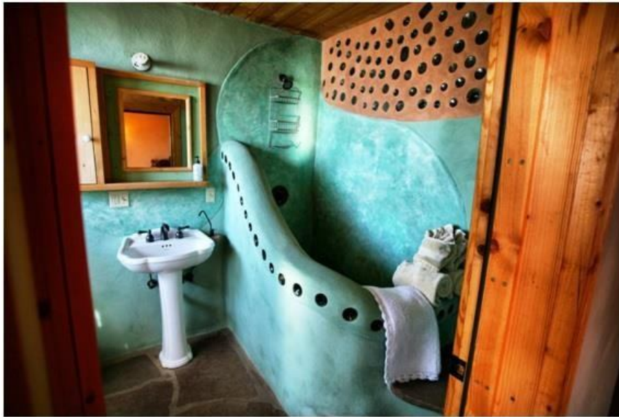
Figura 4. Baño hecho a base de residuos plásticos Fuente https://www.ecoticias.com/residuos-reciclaje/108684/Mike-Reynolds-arquitecto-basura
