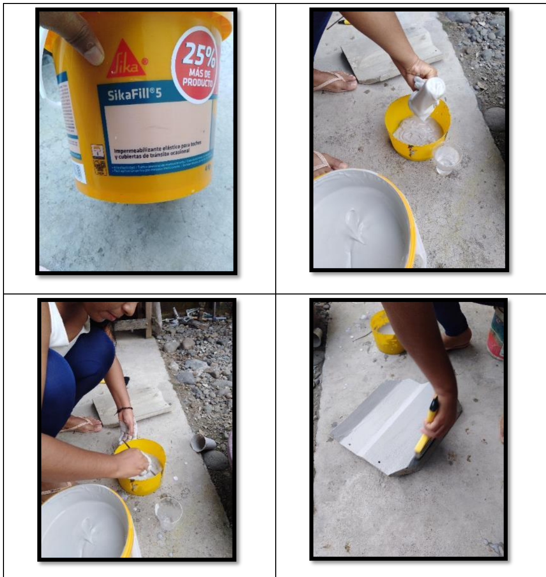
Ilustración 40. Impermeabilización Elaborado por: Lozano Zamora, K (2019)
