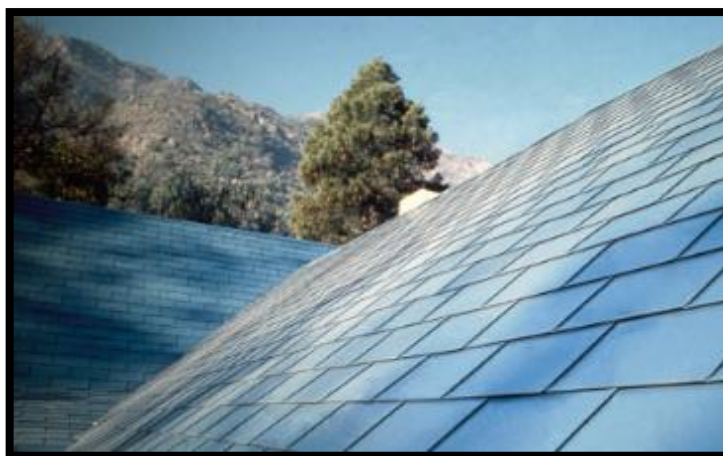
Ilustración 5. Teja de metal Fuente: (Enciclopedia de Clasificaciones, 2017)
