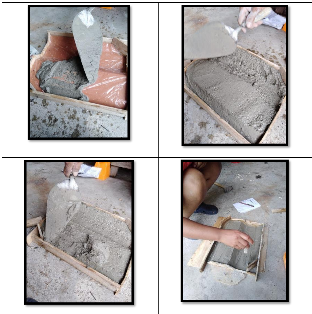
Ilustración 33. Colocación correcta de la mezcla y compactación.
