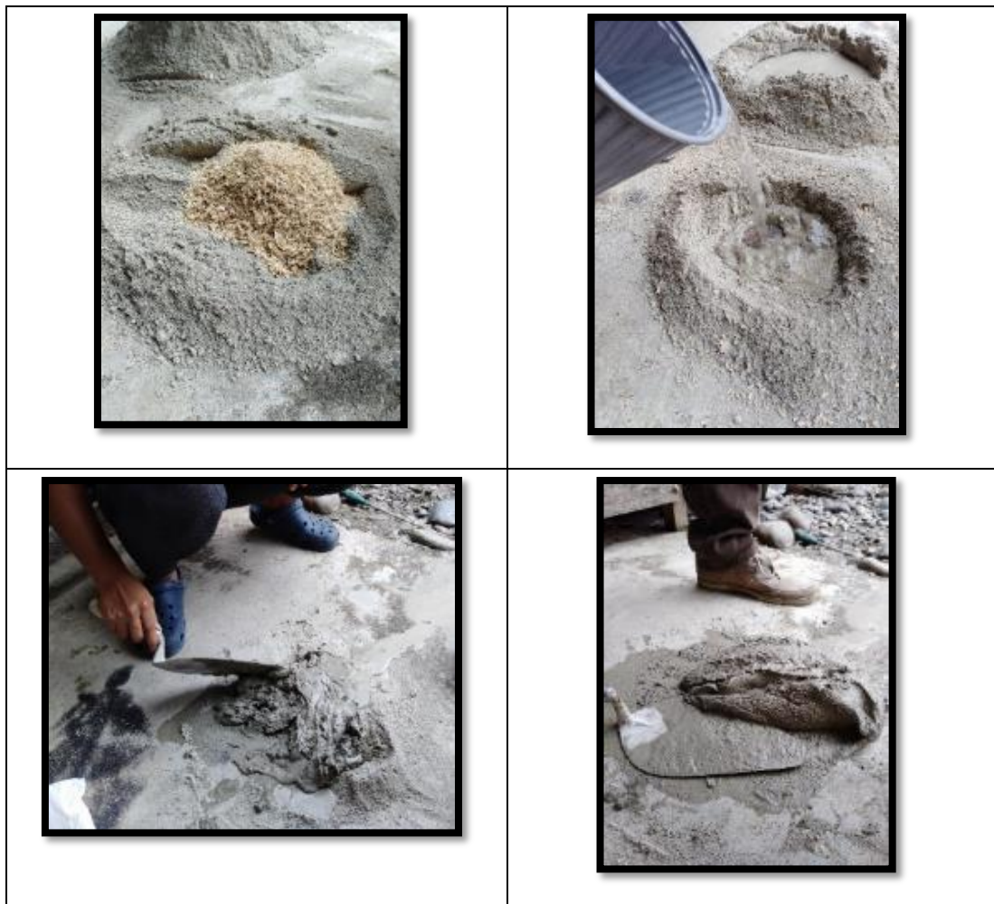
Ilustración 28. Realizar la mezcla con agua, arena húmeda, cemento y tusa de maíz. Elaborado por: Lozano Zamora, K (2019)
