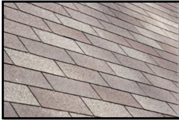
Ilustración 14. Teja normanda Fuente: (Enciclopedia de Clasificaciones, 2017)
