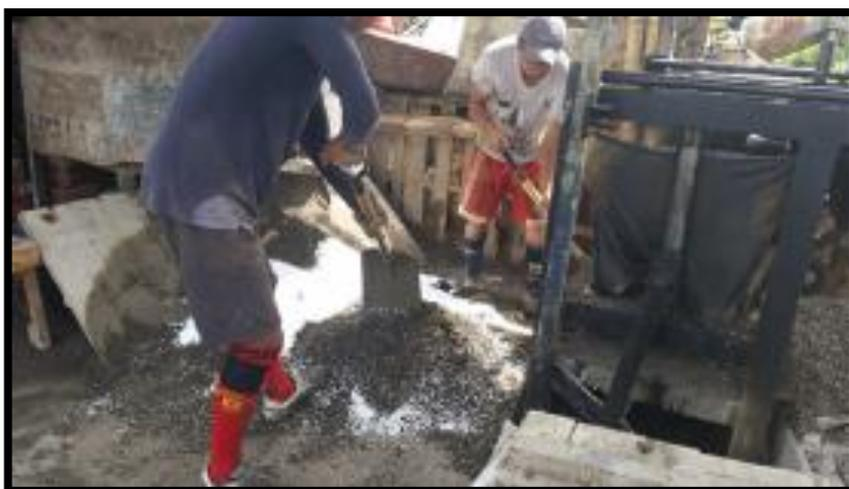
*Imagen 39.* Mezclado manual de componentes.
