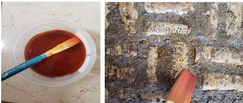
Figura 38: Procedimiento del sellador acrílico Elaborado por: Borja Jiménez, K. & Castillo Moya, N. (2019)
