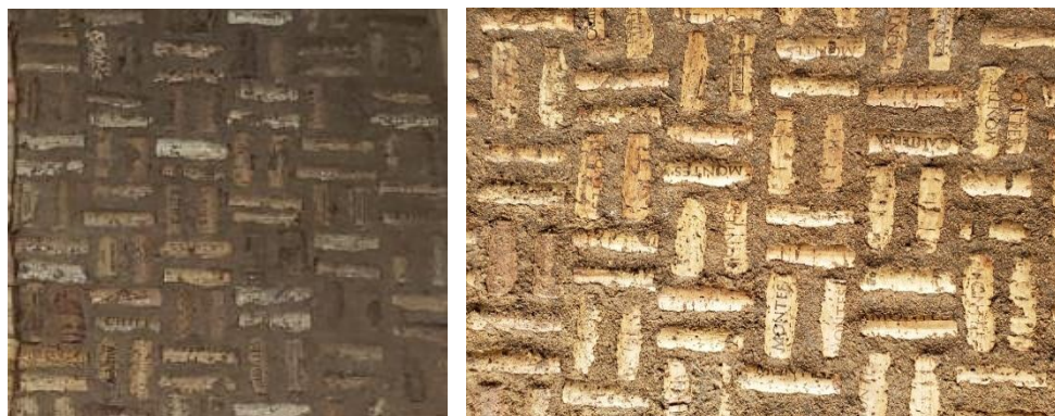
Figura 45: Prueba de humedad
