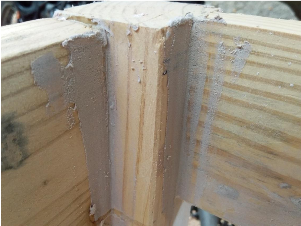
Figura 18. Se procede al masillado. Elaborado por: Morán Rivas, K (2018)
