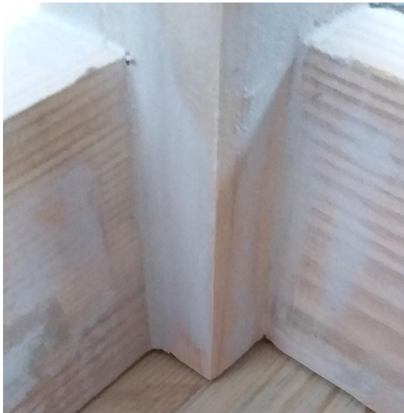
Figura 19. Se realiza el lijado. Elaborado por: Morán Rivas, K (2018)
