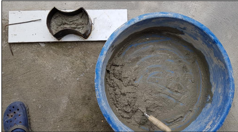
Ilustración 36: Mezcla del adoquín 3 Elaborado por: Fierro Muñoz José, (2019)
