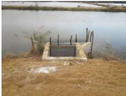
Figura 7 Compuerta de Entrada y Salida Elaborado por: Nieto Rosero, K. (2018)
