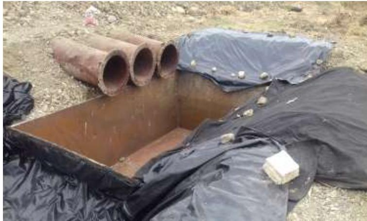
*Figura 36 Tubería de drenaje en el muro de confinamiento*
