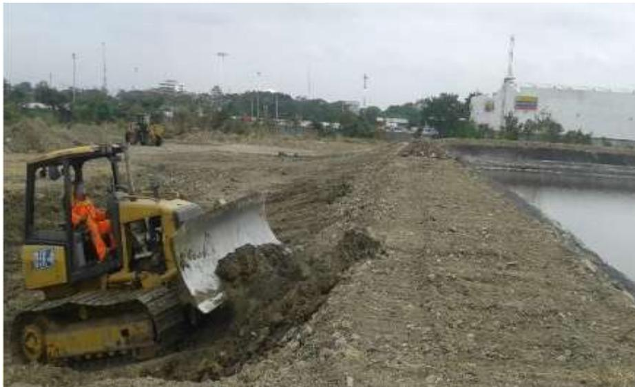
*Figura 71 Reparación de la infiltración del muro en el Tramo III*
