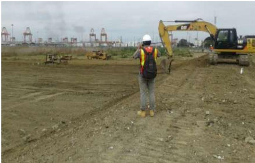
*Figura 53 Compactación y reconfiguración del talud*
