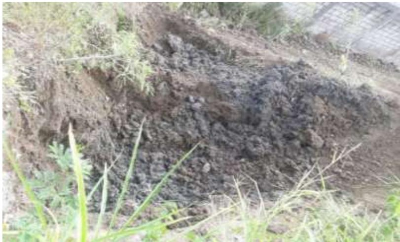
*Figura 75 Material saturado en la corona del muro de confinamiento*
