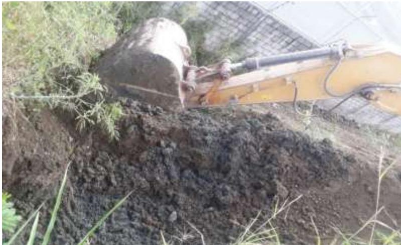
*Figura 74 Excavación del material saturado*
