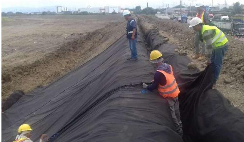
*Figura 57 Colocación del Geotextil N2000 no tejido por tramos*
