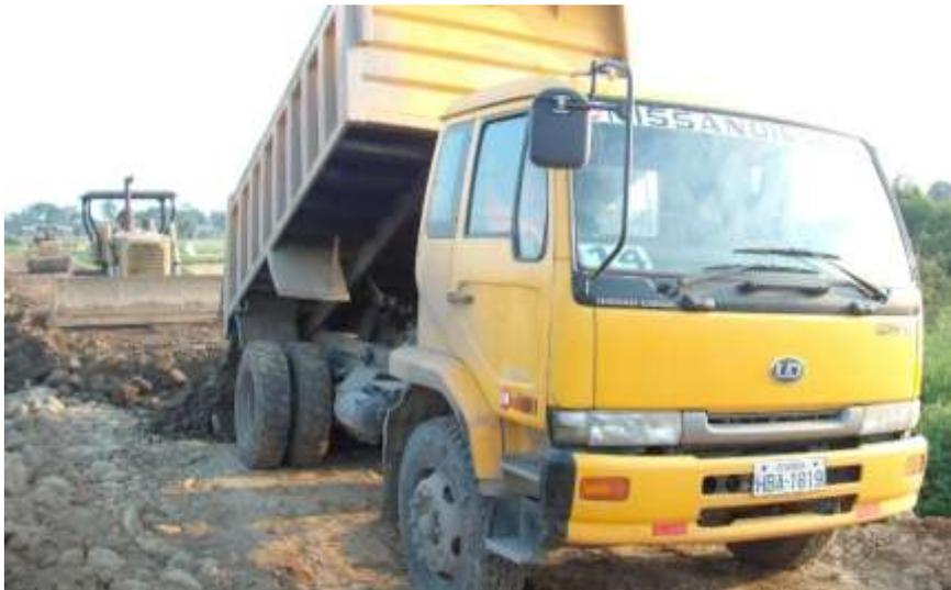
*Figura 3 Muro con material de cascajo importado con volquetas*
