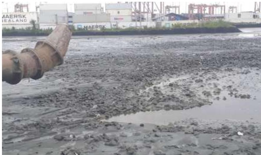
Figura 81 Material dragado dentro del muro de confinamiento
