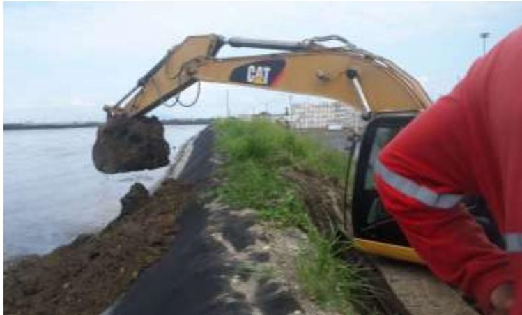
*Figura 76 Retiro del material saturado*
