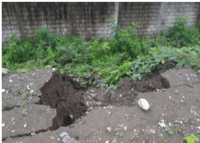
*Figura 73 Agretería en la corona del muro de confinamiento*
