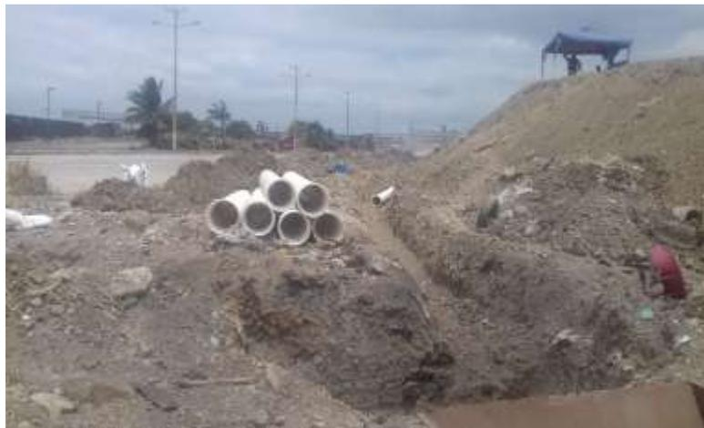
Figura 42 Canal para colocación de tubería para empatar a la caja de revisión de AALL
