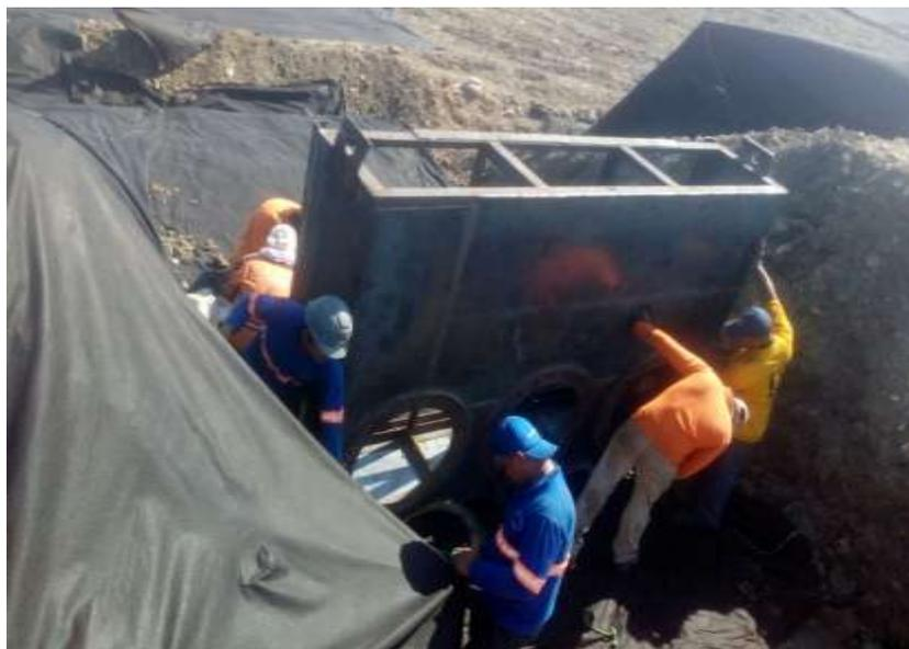
*Figura 60 Colocación de la caja de drenaje*
