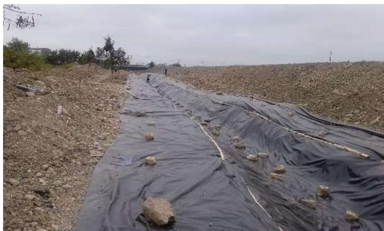
Figura 40 Canal de evacuación con disipadores de energía
