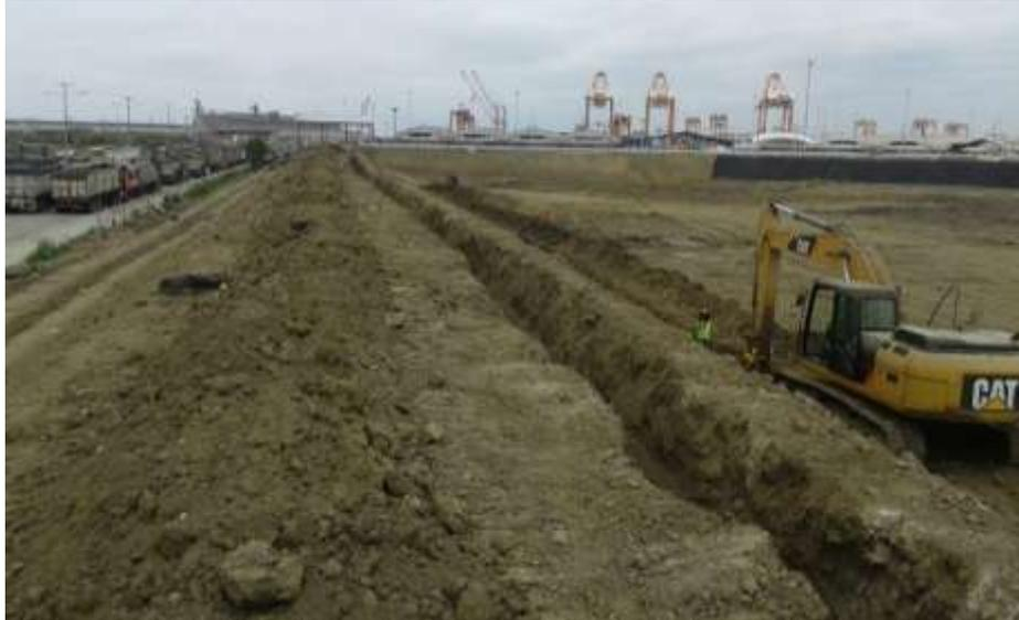
*Figura 55 Excavación de zanja en el corno del muro de contención*
