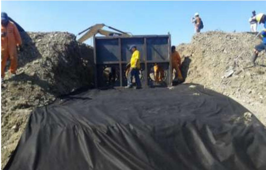
*Figura 61 Colocación de tubería a la caja de drenaje*
