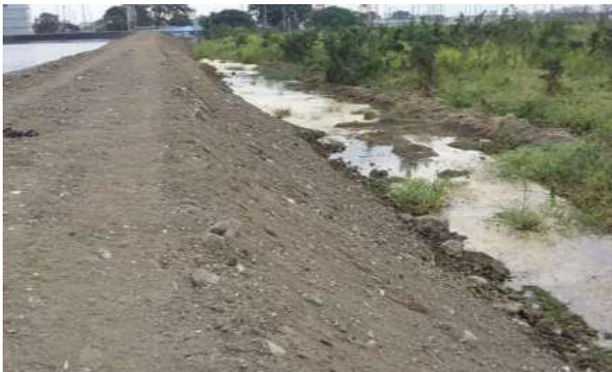
*Figura 69 Filtración en el pie del muro en el Tramo III*
