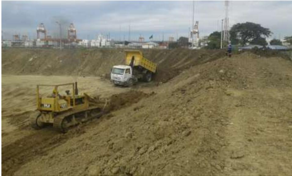
*Figura 51 Reconformación del muro de confinamiento*
