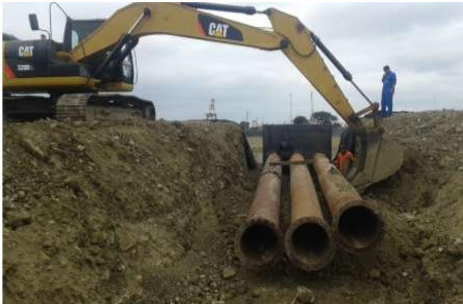
*Figura 62 Colocación de tubería a la caja de drenaje*
