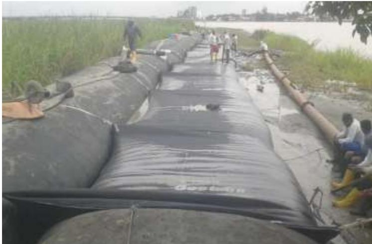
*Figura 5 Muro con Geotubos Isla el Palmar*
