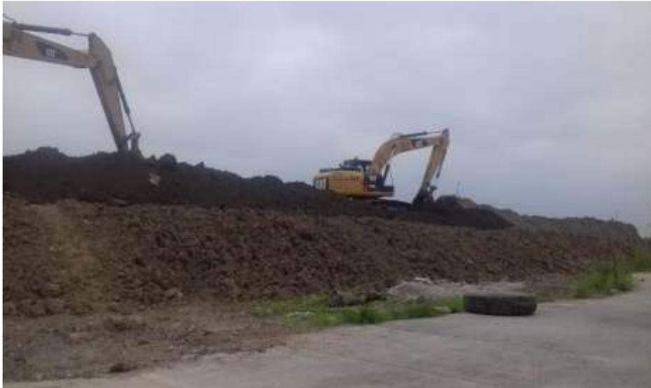
*Figura 50 Reconfiguración del muro con excavadora y su compactación*
