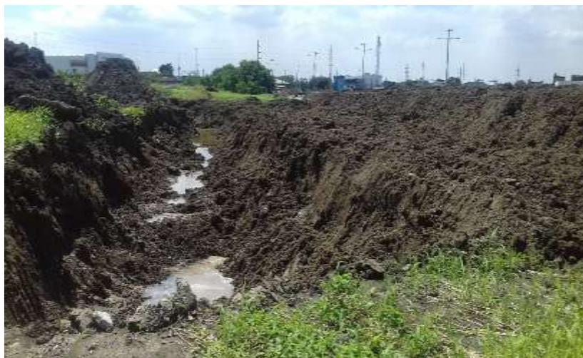
*Figura 47 Excavación del dentellón 3m ancho y 1m profundidad*
