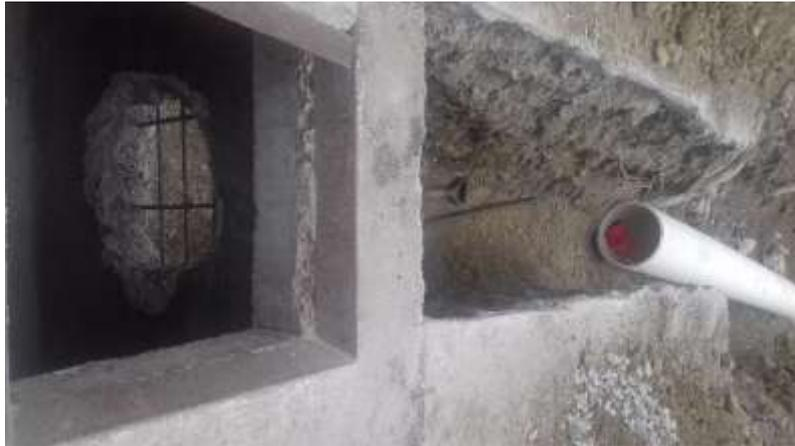
Figura 43 Empate a la caja de revisión de AALL con la tubería
