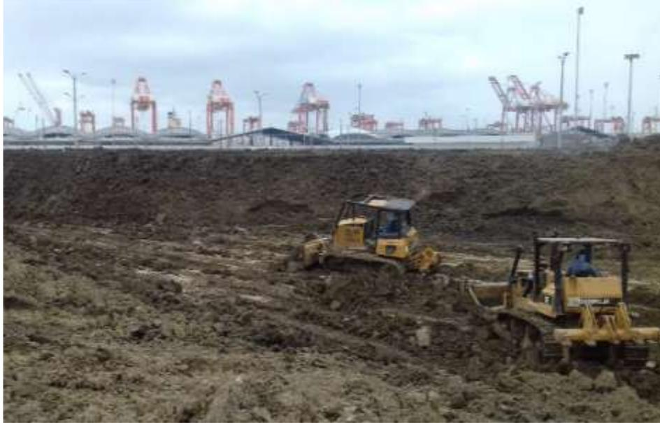
*Figura 49 Arrastre de material para reconfigurar el muro con tractores D6*
