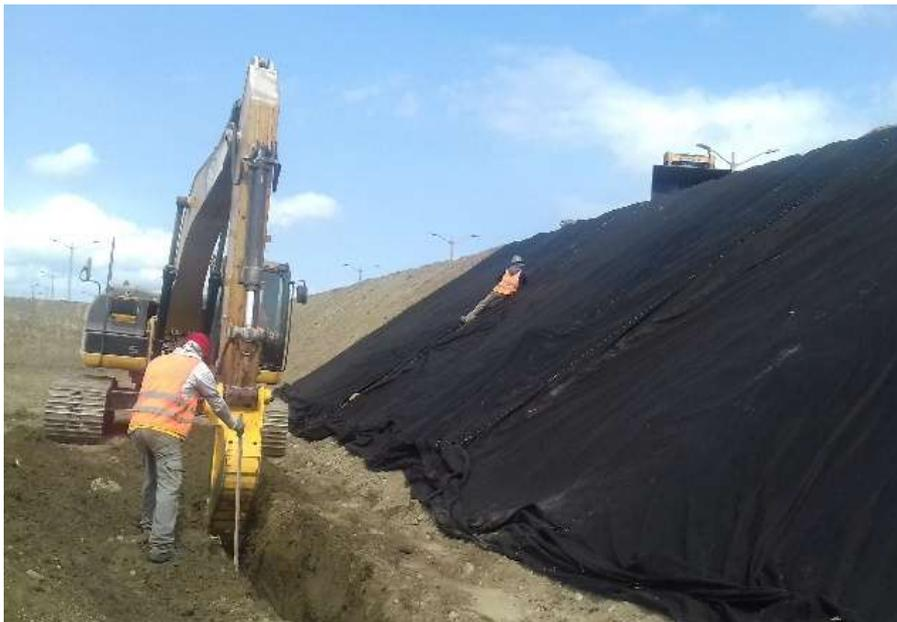
*Figura 56 Excavación de zanja al pie del talud del muro de contención*
