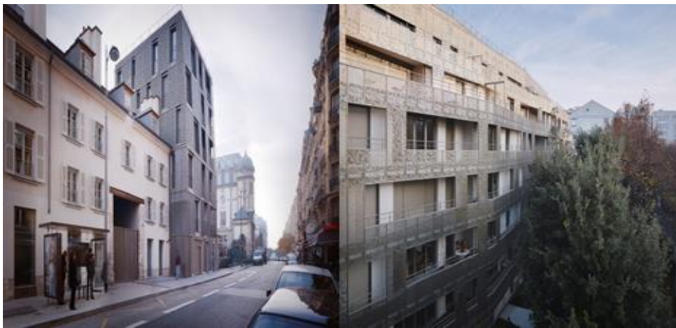
Ilustración 4. Fachada frontal y lateral de la residencia. Fuente: Ver archivo de citas bibliográficas.
