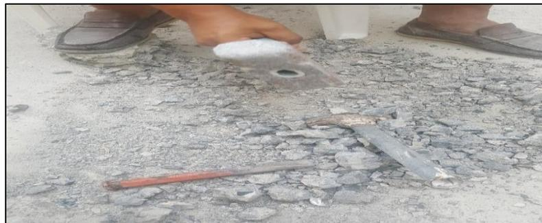
**Figura: 29 Trituración Manual de Escombros de Hormigón.**
