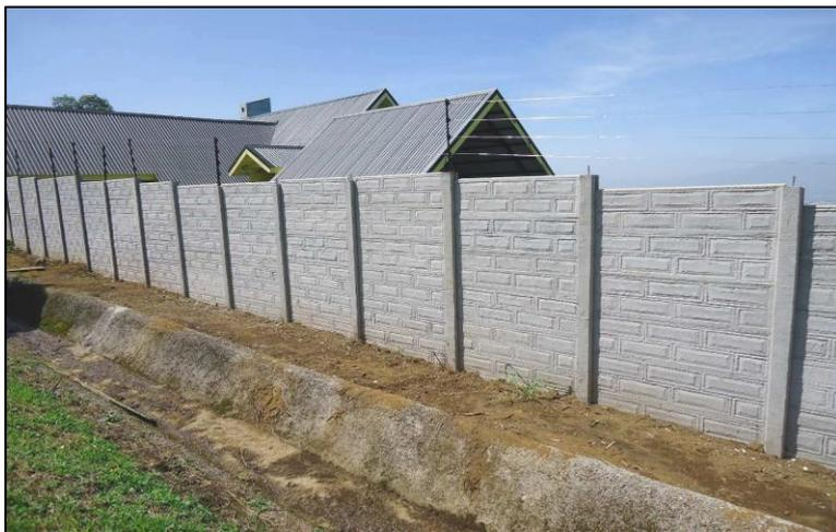
*Figura: 16 Bloque Revocado no estructural, cerramiento*
