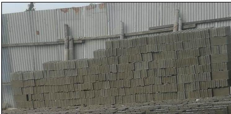
*Figura: 25 Almacenamiento y Apilamiento de Bloques*
