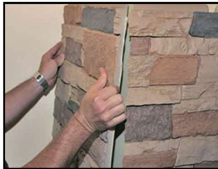
Figura 47. Instalación de la placa decoativa.
