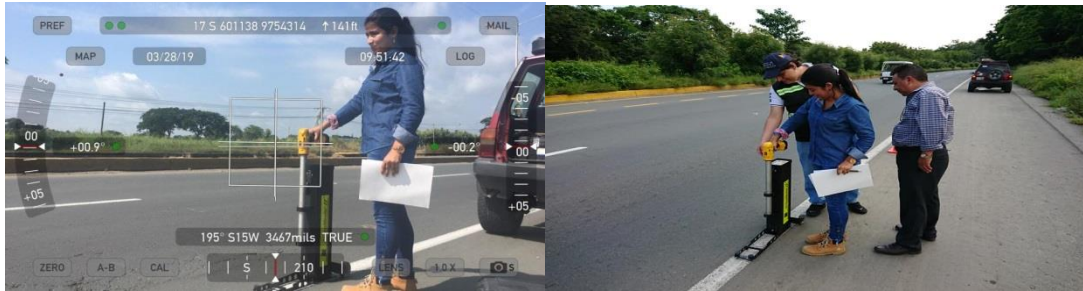
Ilustración 7. Toma de Retro-reflectividad en Señalización Horizontal Tomado por: Alvarez Barrionuevo A.(2019)
