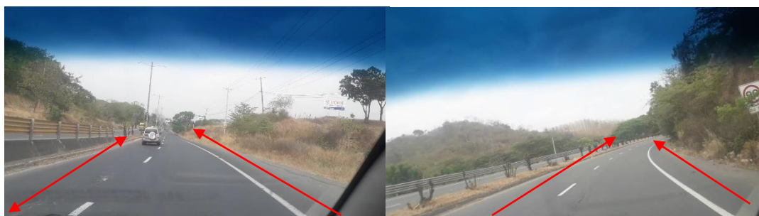
Ilustración 11. Ausencia De Señalización Complementaria Tomado por: Alvarez Barrionuevo A. (2019)
