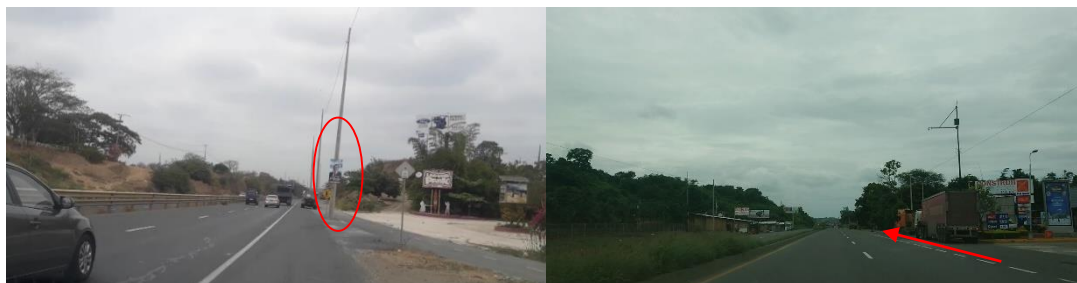
Ilustración 5. Línea de Espaldón Incorrecta, Poste Muy Cerca De Espaldón Tomado por: Alvarez Barrionuevo A. (2019)
