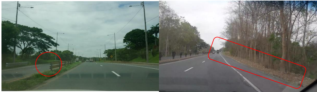
Ilustración 18. Guardavía No Tiene Amortiguador, Falta De Guardavías Protegiendo La Vegetación
