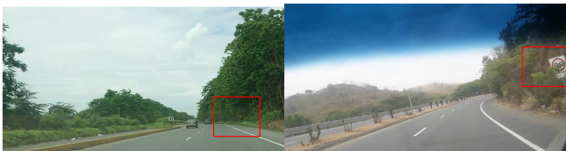
Ilustración 15. Señalización Vertical Obstruida Por Vegetación
