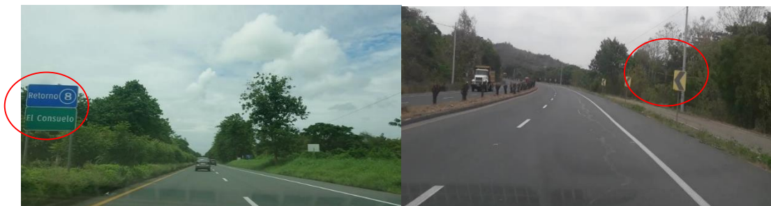
Ilustración 14. Poca Retroreflectivad En Señalización Vertical
