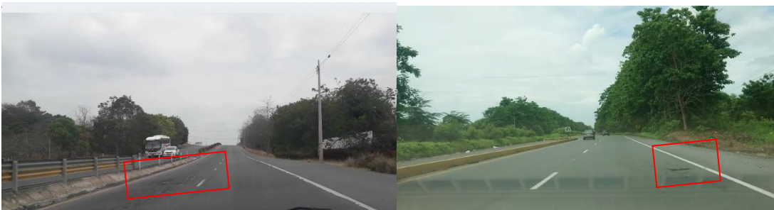
Ilustración 3. Superficie De Rodadura Irregular Tomado por: Alvarez Barrionuevo A. (2019)
