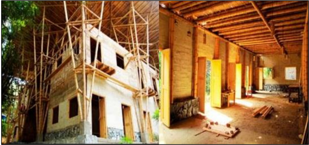
Imagen 31: Colegio de las aguas Montebello, Cali – Colombia. Fuente: (Bappler, 2014)
