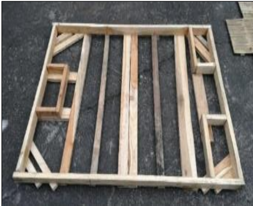
Imagen 52: Encofrado de madera.
