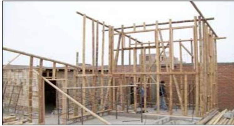
Imagen 38: Construcción con caña guadua.
