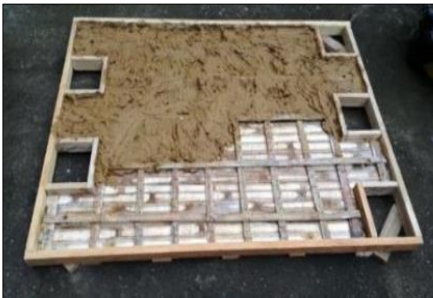
Imagen 70: Colocación de la mezcla.
