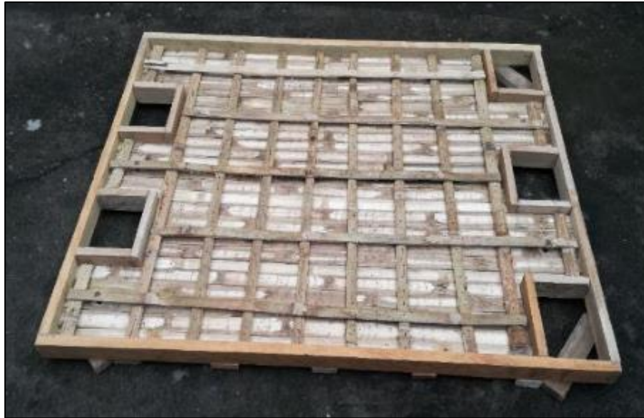
Imagen 69: Colocación de caña guadúa en el encofrado.
