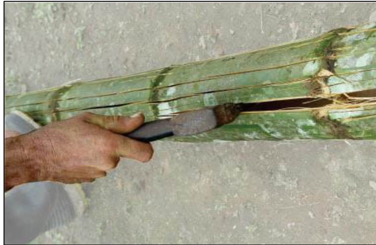
Imagen 26: Corte longitudinal de la caña. Fuente: (Morán Ubidia, 2015)
