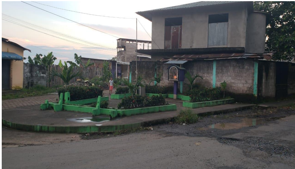
Ilustración 6. Estado actual de banca en parque 2 coop. 24 de mayo
