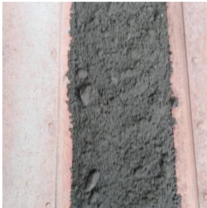
Imagen 26. Concreto saliendo de la mezcladora
