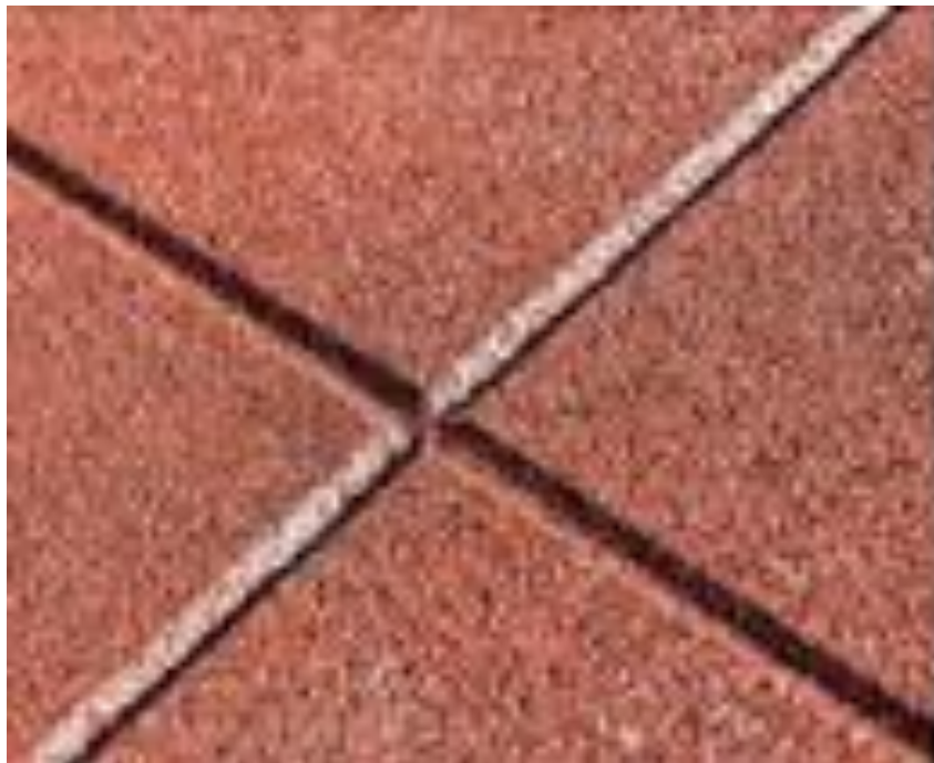
Imagen 5. Pavimento de Caucho 1 Fuente: EcoNaturals, (2014)
