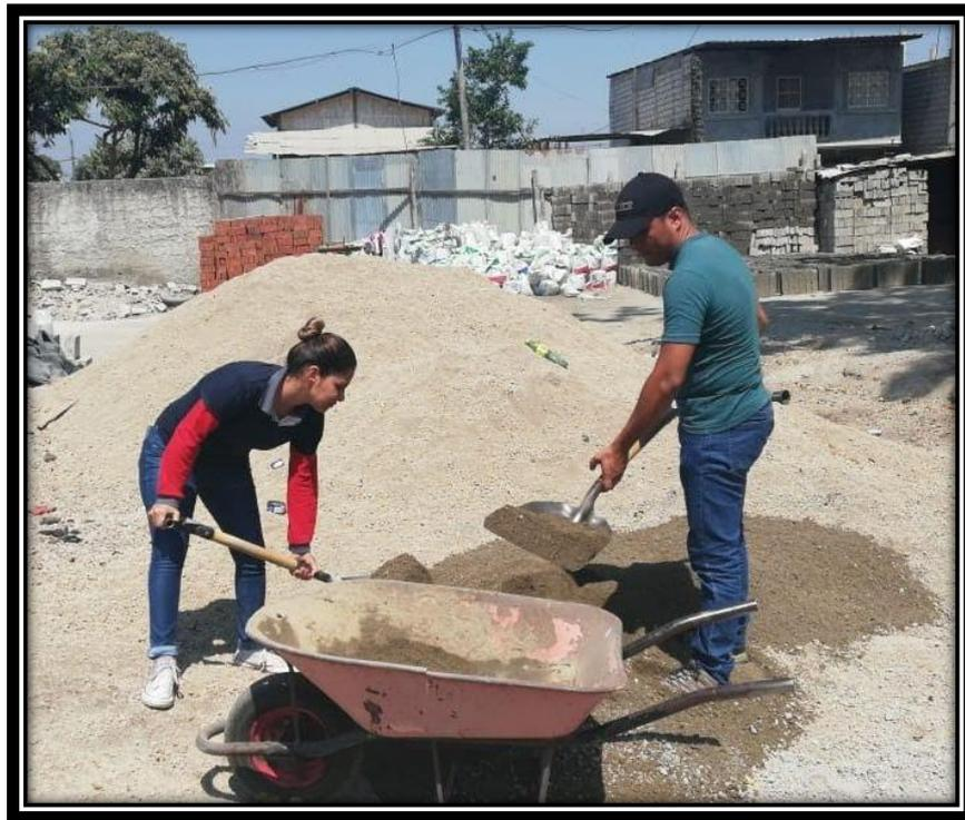
Ilustración 9 Mezclado manual de los agregados
