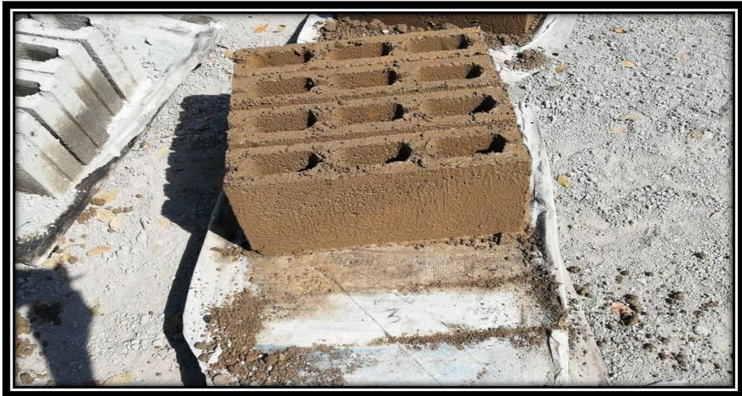
Ilustración 23 Secado de los prototipos de bloques, muestra 1, muestra 2, muestra 3 a los 30 minutos
