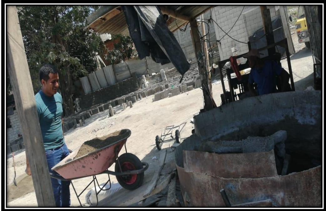
Ilustración 10 Material mezclado puesto en la máquina mezcladora
