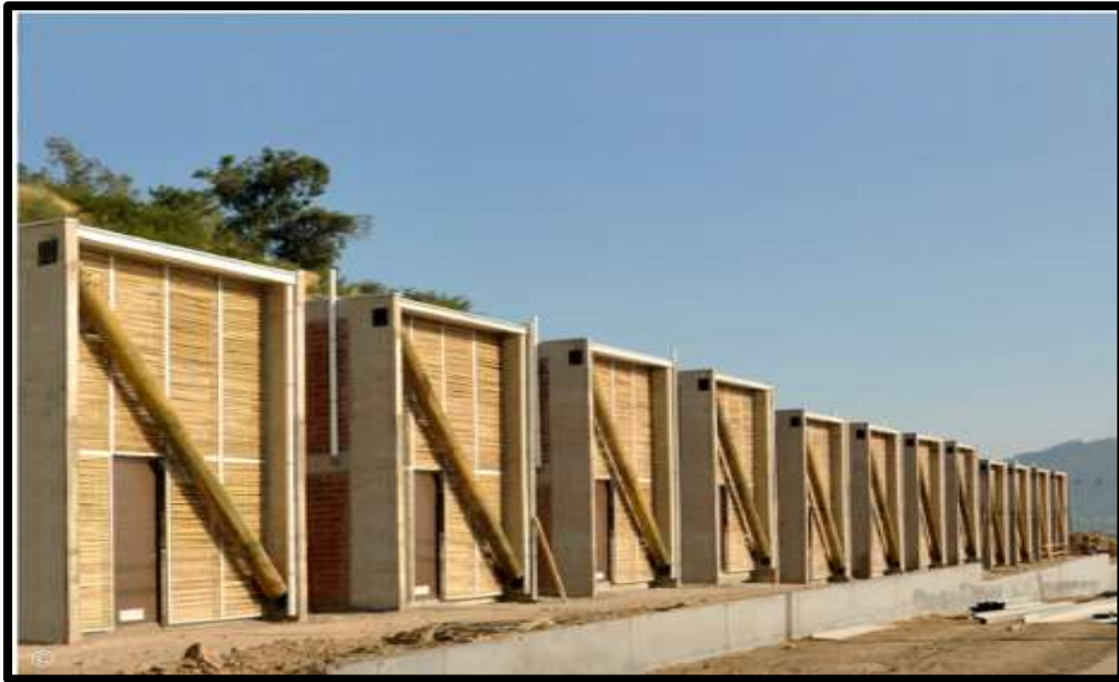
Imagen 15. Casa con marco de hormigón armado, Chile Fuente: Undurraga Devés Arquitectos (2013)
