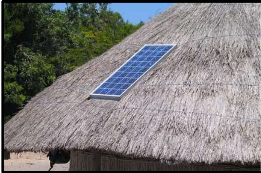
Imagen 4. Cubierta tradicional implementada a paneles solares Fuente: Arquitecto Salud (2017)
