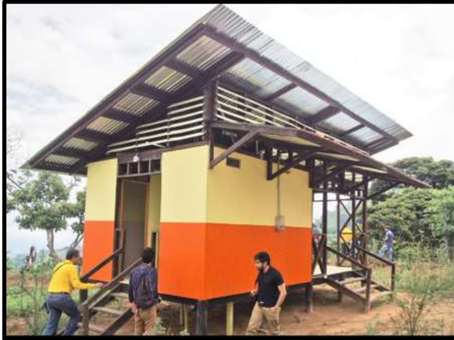
Imagen 13. Casa de entramado de madera seca, Colombia Fuente: Ensamble de arquitectura integral (2017)
