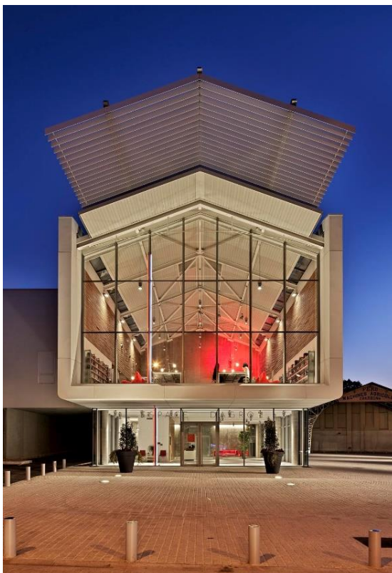
Ilustración 8 Vista Frontal del centro cultural Auneau FUENTE: Patrick Mauger,2012
