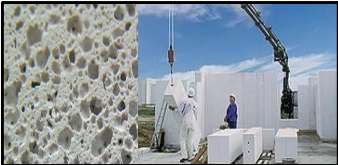
Figura 8. Hormigón celular: porosidad y ensamble Fuente: TOP-WERK Group, 2013
