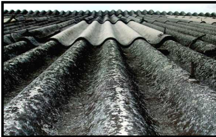
Figura 16. Planchas de asbesto para el techo Fuente: (Castells, 2013)
