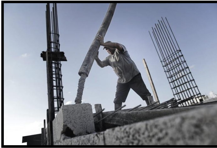
FIGURA 15. COLOCACIÓN DE CEMENTO EN UNA CONSTRUCCIÓN Fuente: (Ulate, 2014)
