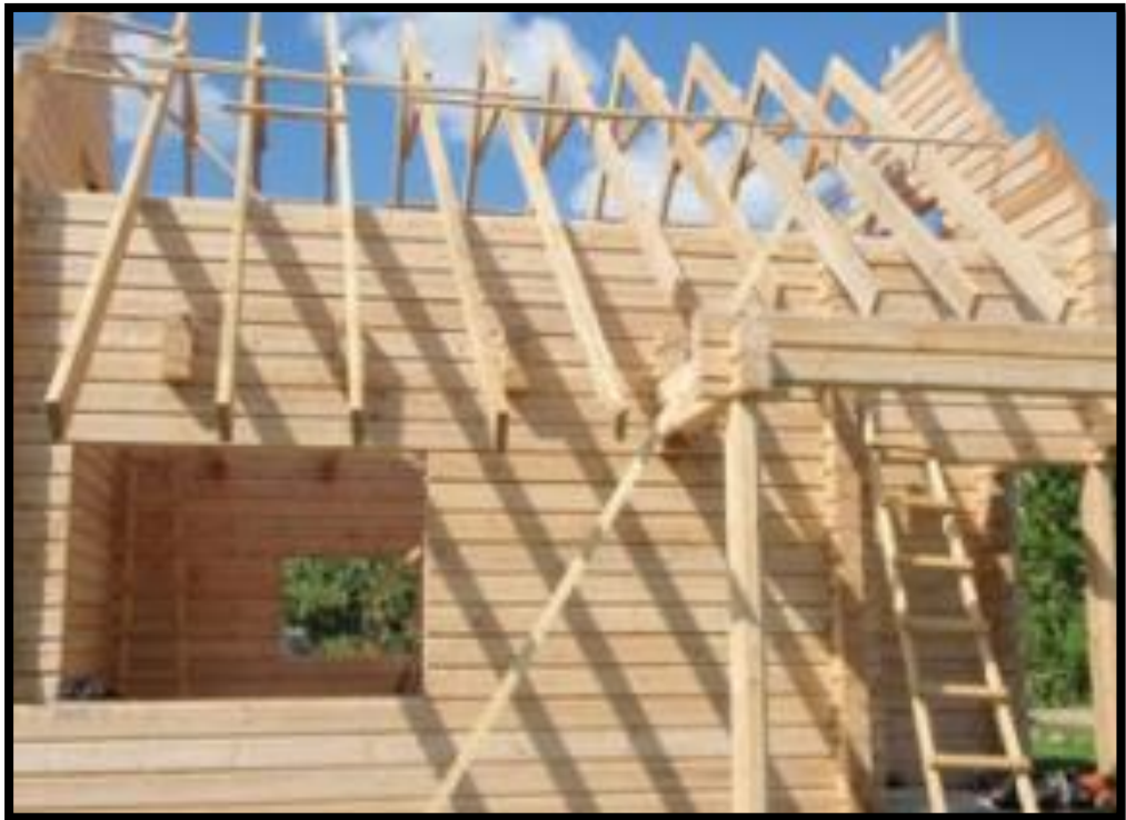
FIGURA 11. CONSTRUCCIÓN CON MADERA Fuente: (Grupo Gobia, 2015)
