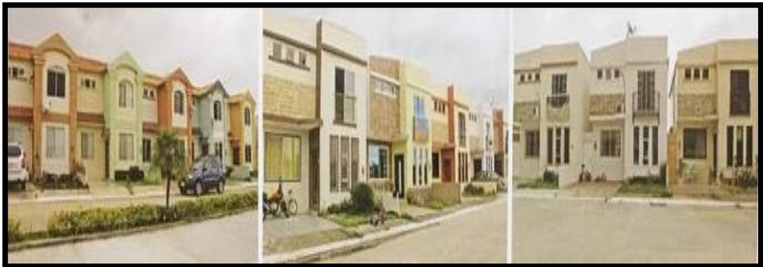
Ilustración 4. Técnica: Bahareque cementado Fuente: Urbanización Intissar, 2017
