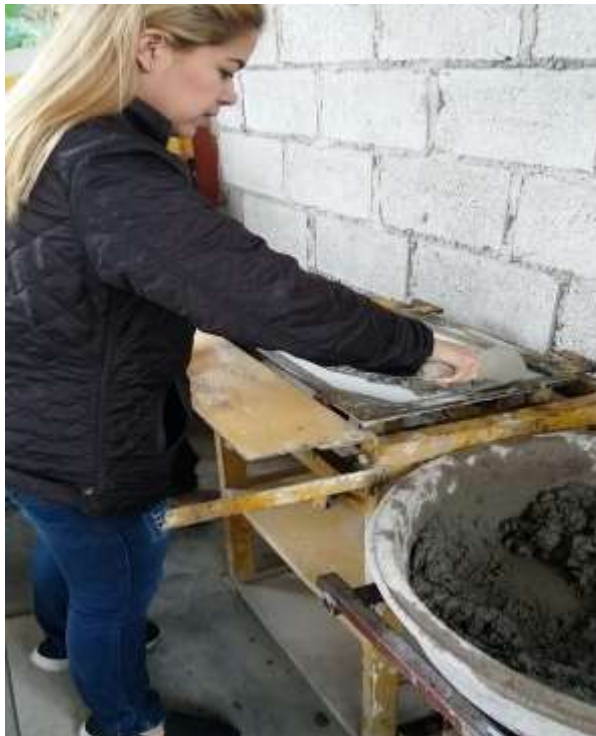
Figura 49. Aplicación de la dosificación en el mortero.
