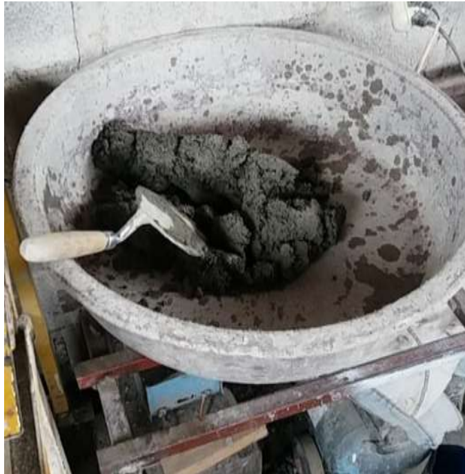
Figura 39. Mezcla de los componentes (cemento, arena y agua)
