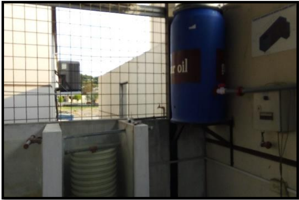
Ilustración 2 Limpieza de tanque inicial para almacenamiento de aguas residuales doméstica Fuente: (Los Autores, 2018)
