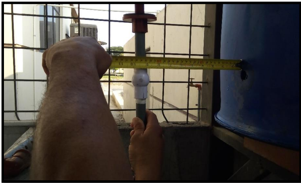
Ilustración 3 Medición de Tuberías en Salida del Tanque Fuente: (Los Autores, 2018)
