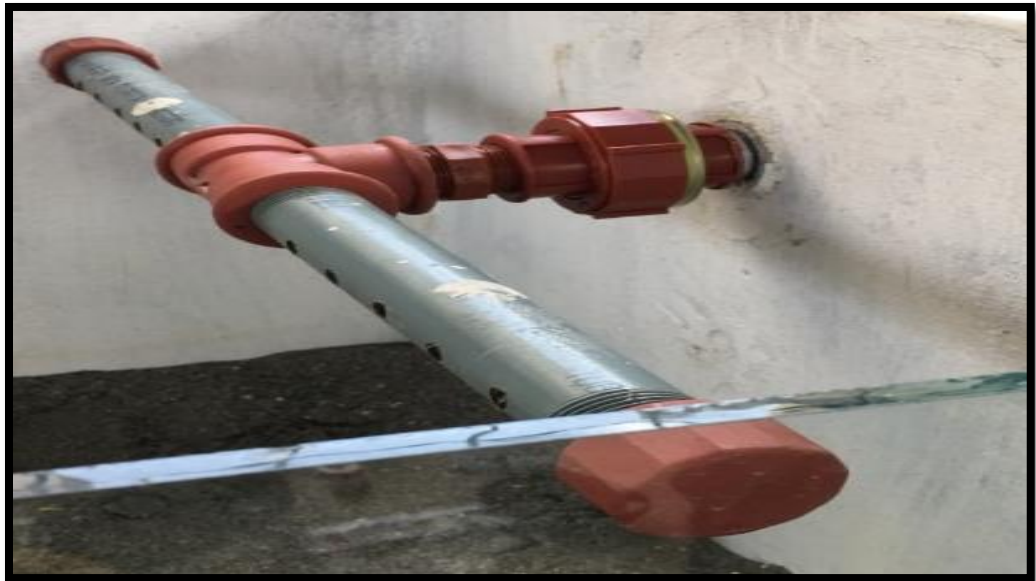
Ilustración 9 Flauta con Perforaciones de Diámetro \frac{3}{4} mm
