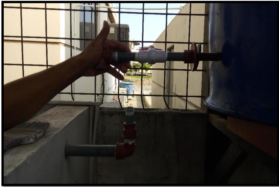
Ilustración 4 Colocación de Tuberías en la Salida del Tanque Fuente: (Los Autores, 2018)
