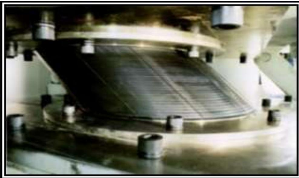
*Figura 2 – Aisladores sísmicos de caucho*
