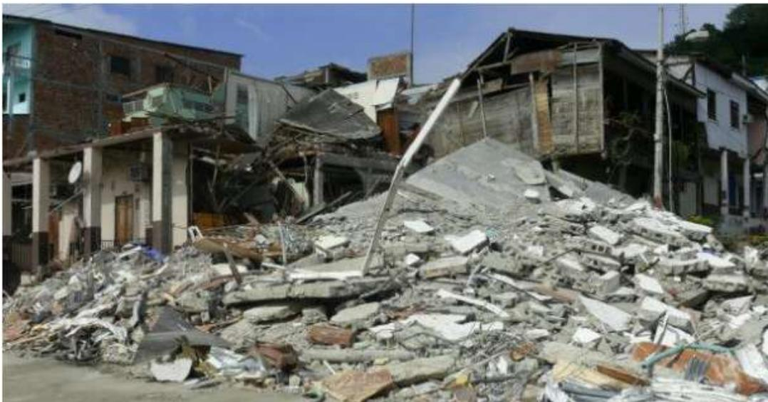
*Imagen 5 - Bahía de Caráquez, derrumbe de construcción de hormigón afecta paredes de casa.*
