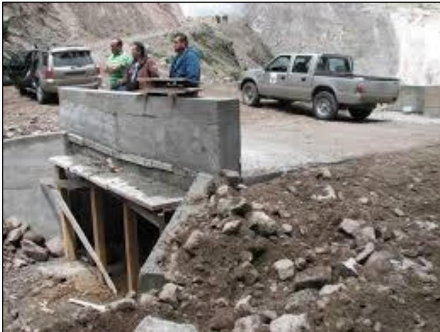
**Figura 2.** Funcionamiento transversal de ducto cajón.
