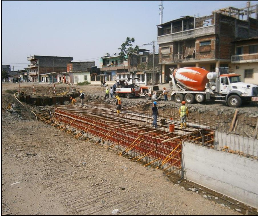
**Figura 1.** Funcionamiento longitudinal de ducto cajón.
