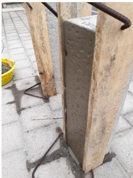
**Gráfico 26 Elemento de Hormigón con reglas laterales para enlucido**
