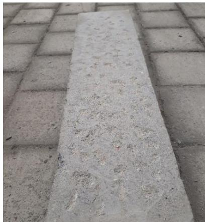
**Gráfico 25 Elemento de Hormigón aplicado el proceso de picado.**
