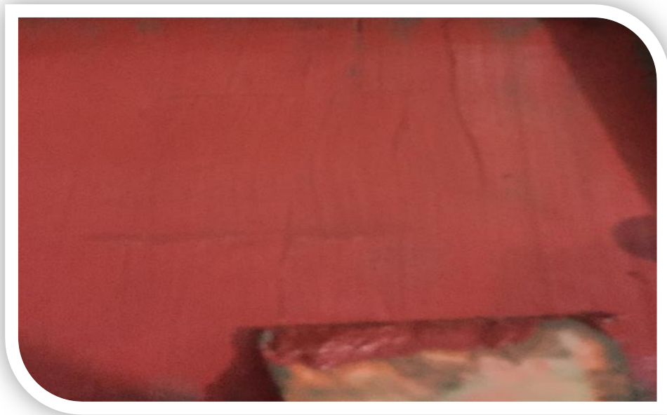
Fotografía 58. Compactación de un Color Sobre la Argamasa.
