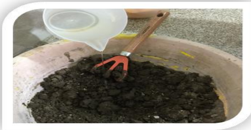
Fotografía 25. Hidratación de la Argamasa.
