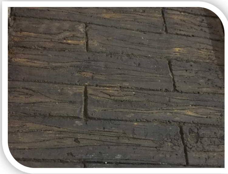
Fotografía 62. Argamasa con Superficie de Imitación de un Piso de Tablones sin Sellador.
