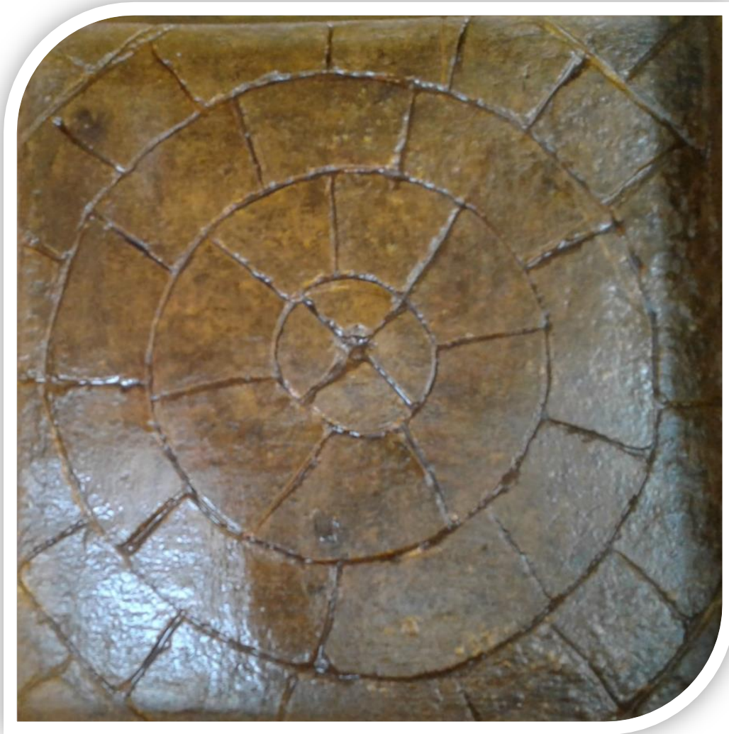
Fotografía 42. Piso Decorativo de Argamasa del Terreno y Cemento con Resina y Pigmento Mineral.
