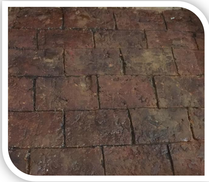
Fotografía 67. Piso Decorativo con Argamasa del Terreno y Cemento, Acabado Tipo Ladrillo.
