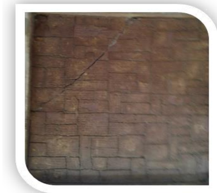
Fotografía 55. Piso Decorativo de Argamasa del Terreno y Cemento Utilizando el Pigmento Mineral en Exceso.
