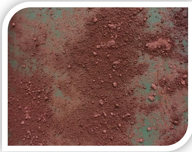
Fotografía 56. Aplicación del Pigmento Mineral Sobre la Argamasa Compactada y Húmeda.
