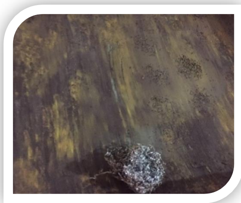
Fotografía 32. Aplicación del Texturizado.
