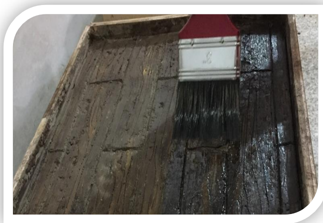
Fotografía 34. Aplicación del Sellador.
