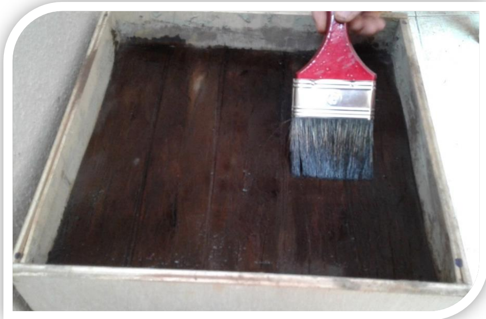
Fotografía 44. Aplicación del Tinte Para Madera Sobre el Piso.
