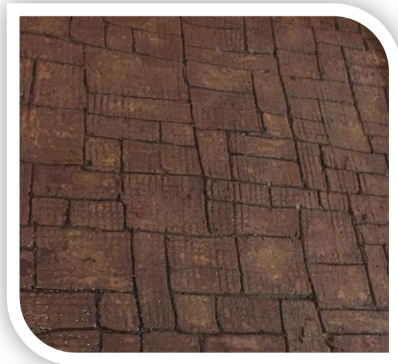
Fotografía 66. Piso Decorativo con Argamasa del Terreno y Cemento, Acabado Tipo Piedra.
