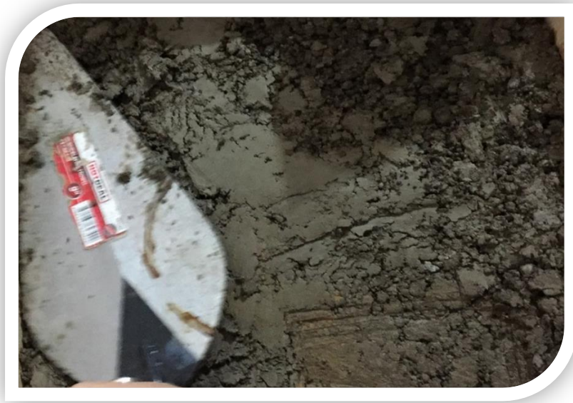
Fotografía 28. Compactación de la Argamasa.
