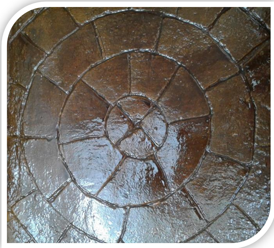
Fotografía 64. Piso Decorativo con Argamasa del Terreno y Cemento, Acabado Tipo Adoquín Café Oscuro.
