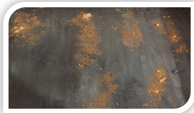
Fotografía 57. Aplicación de dos Colores de Pigmento Mineral Sobre la Argamasa Compactada y Húmeda.
