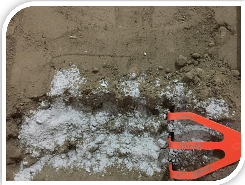
Fotografía 22. Aplicación de Cemento Sobre el Suelo.
