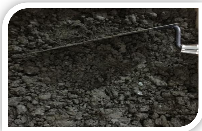
Fotografía 27. Nivelación de la Argamasa.
