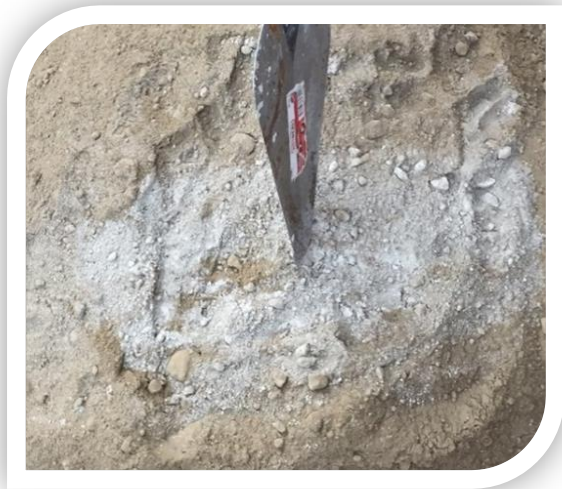
Fotografía 23. Mezclado del Suelo y el Cemento.
