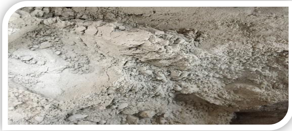
Fotografía 12. Mezclado de Cemento y Suelo.
