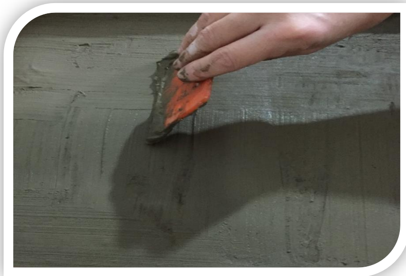
Fotografía 29. Consolidación de la Argamasa.
