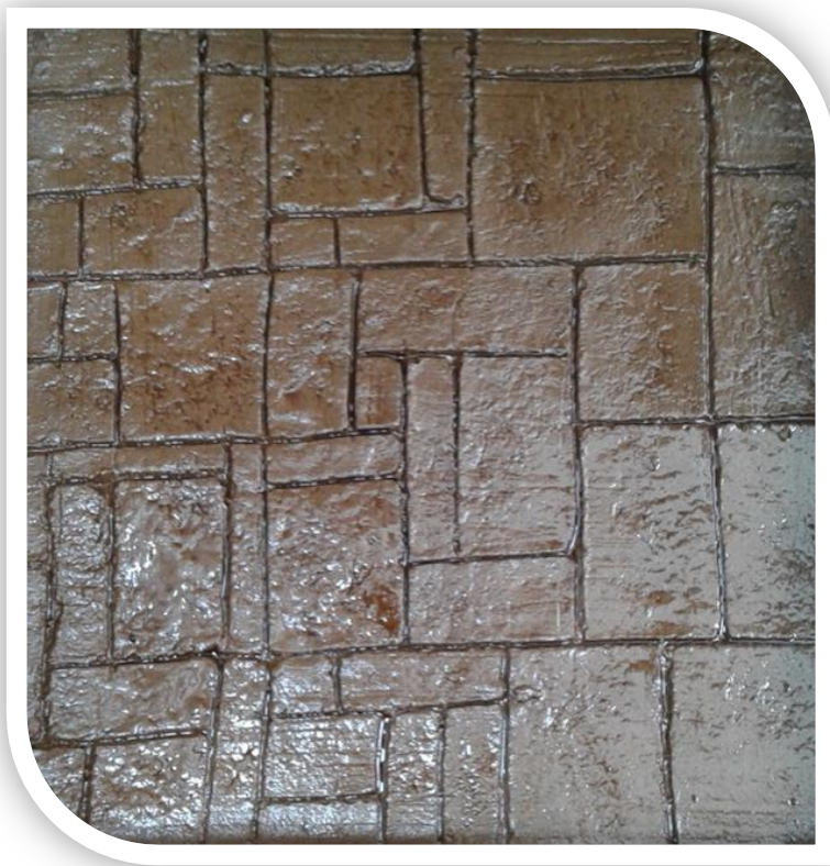
Fotografía 71. Piso Decorativo con Argamasa del Terreno y Cemento, Acabado Tipo Piedra de Color Uniforme.
