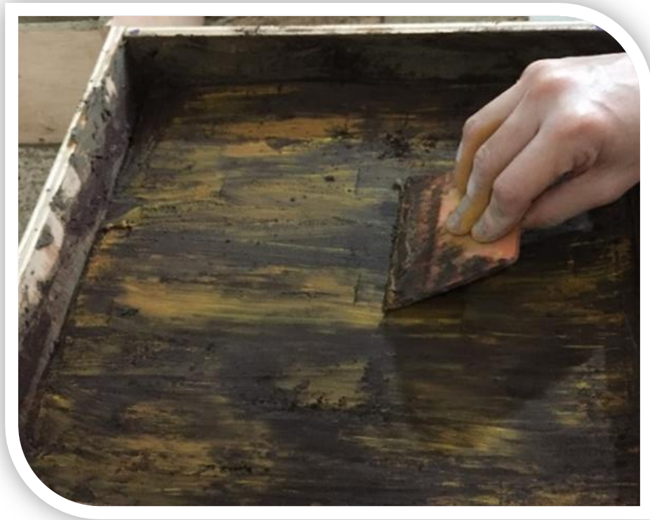
Fotografía 59. Compactación de dos Colores Sobre la Argamasa.
