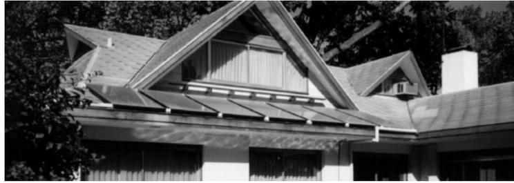
*Figura 31.* Colectores planos con cubierta de vidrio
