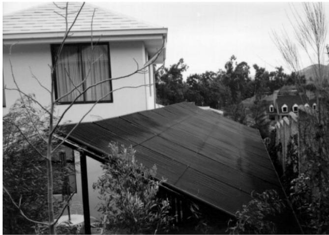
*Figura 32.* Colectores planos sin cubierta de vidrio
