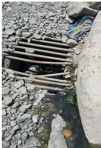
Foto 3: Canales de evacuación y sumideros para aguas lluvias del sector de Barrio Lindo en mal estado
