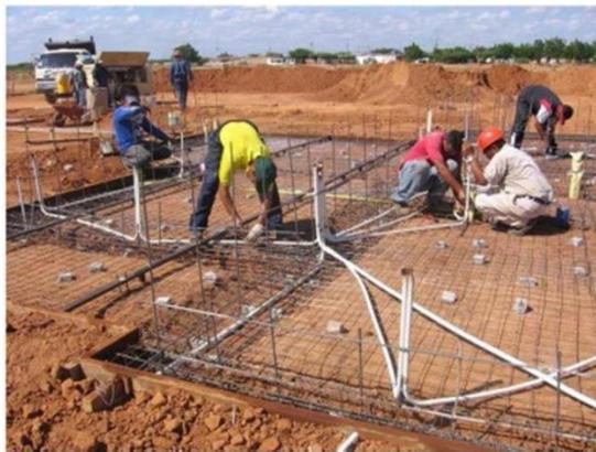
Figura 28. Armado de vigas de cimentación
