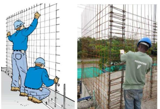
**Figura 37.** Armado y traslape de malla electro soldado de pared
