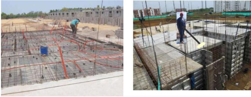
**Figura 32.** Colocación de malla sismo resistente electro soldable
