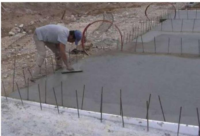
**Figura 34.** Colocación de Sika Antisol y corrección de fallas
