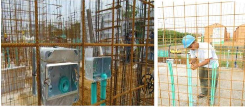
**Figura 38.** Instalación del sistema eléctrico
