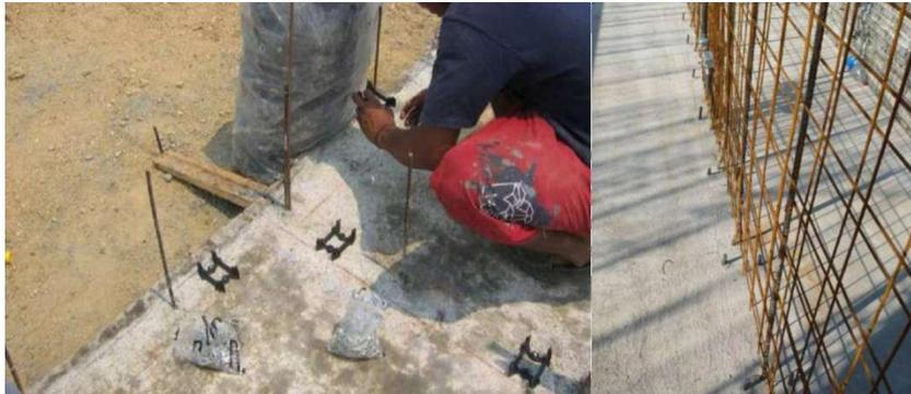
**Figura 36.** Colocación del pin de tope
