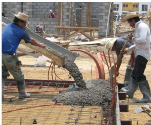
**Figura 33.** Fundición de losa de cimentación
