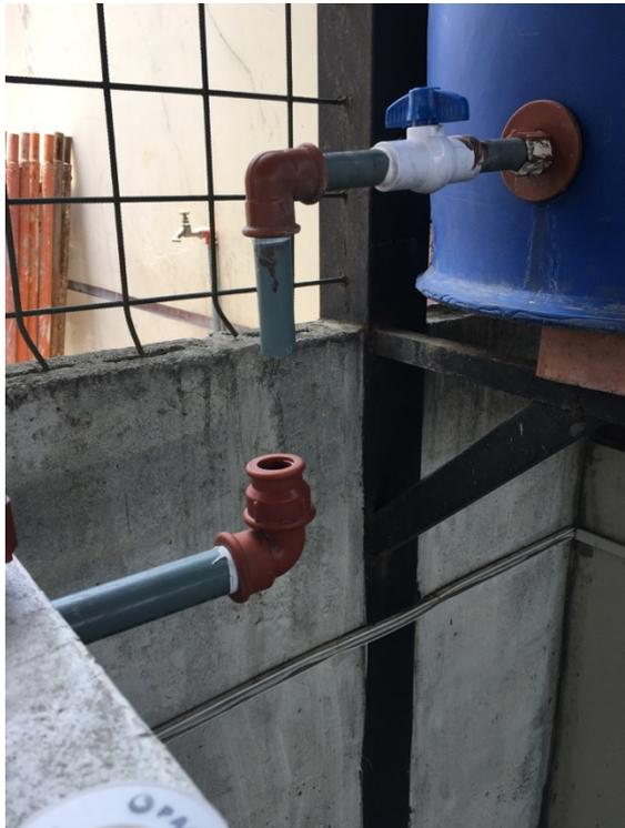
Figura 29. Colocacion de tuberias y tanque de agua
