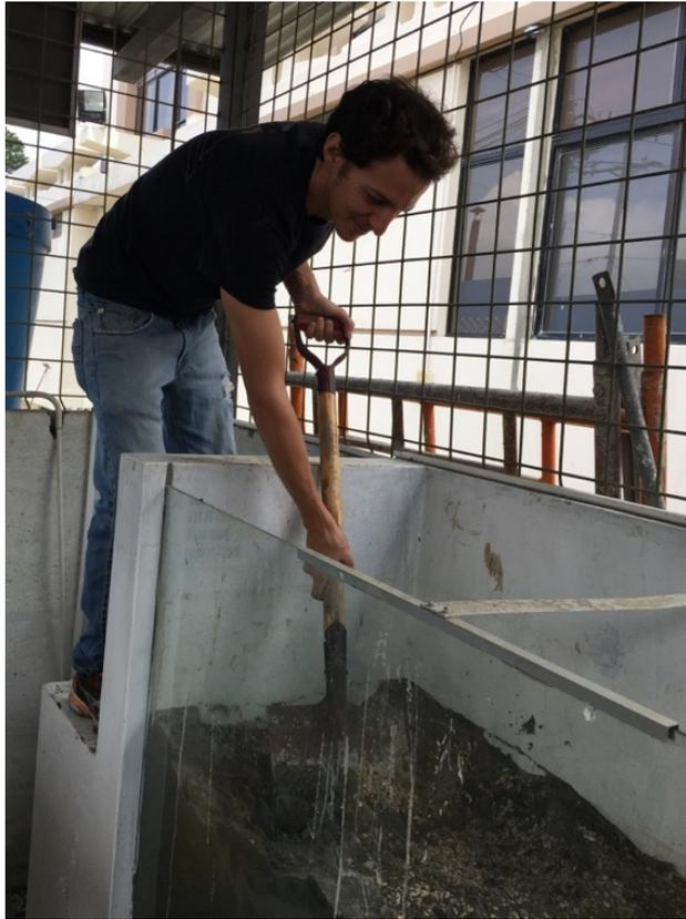
Figura 14. Retiro de Lecho Filtrante.
