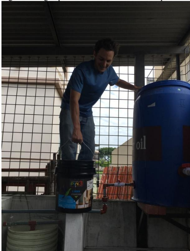
Figura 49. Colocacion de agua residual gris
