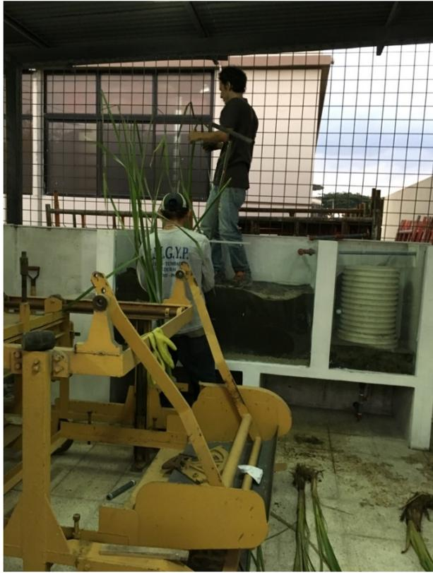
Figura 42. Sembrado de junco de río en el humedal artificial.
