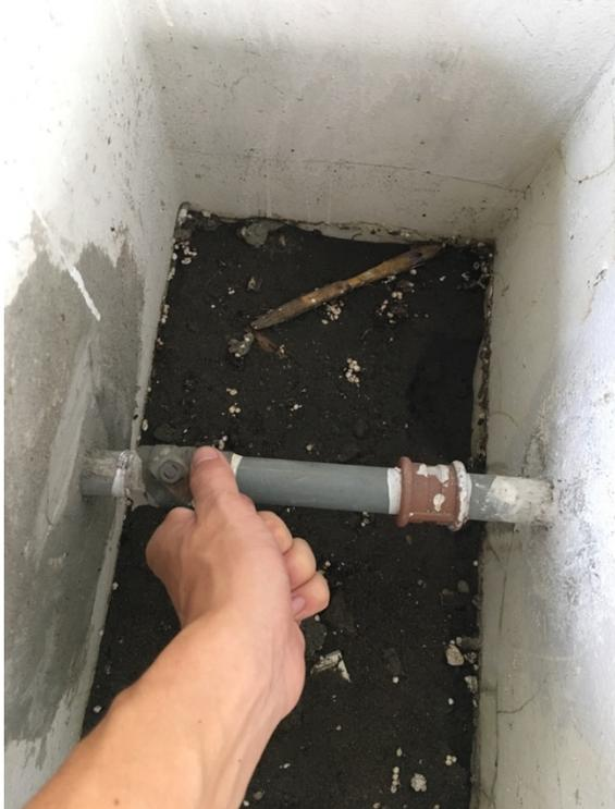
Figura 77. Válvula de salida abierta.
