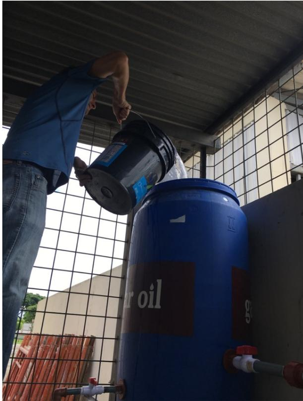
Figura 50. Colocacion de agua residual gris.
