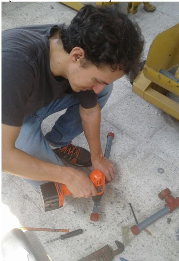
Figura 33. Perforacion en tubería de entrada
