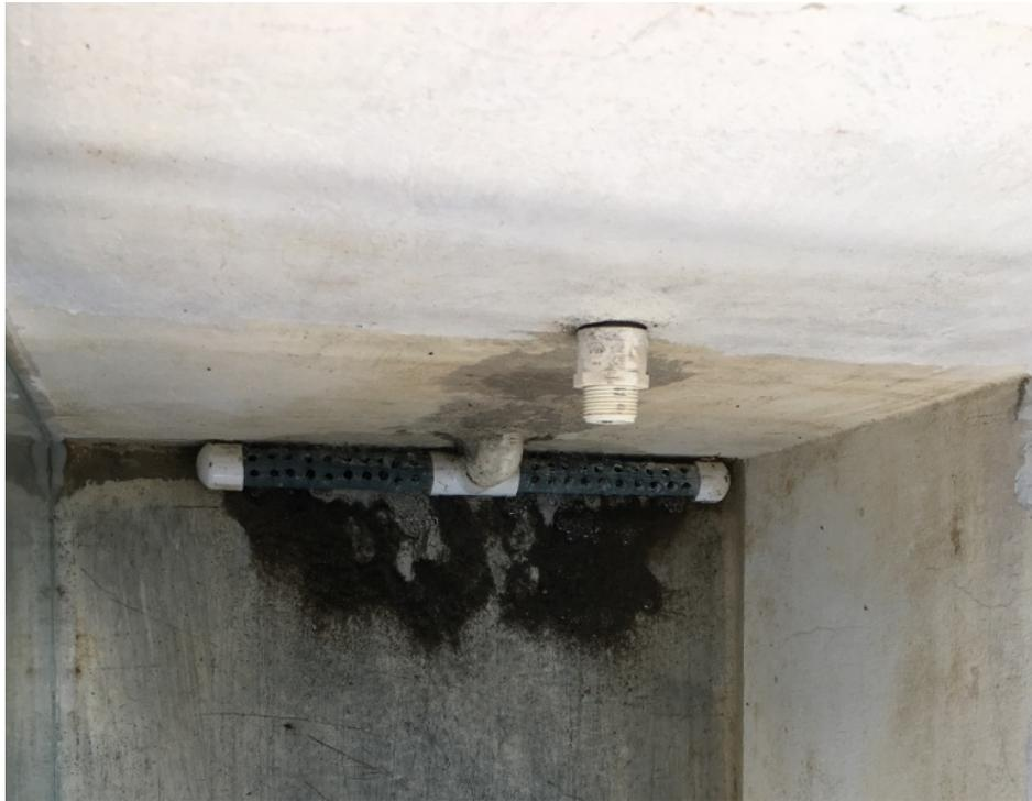
Figura 16. Limpieza de salida de agua del humedal artificial, se encontraba tapado
