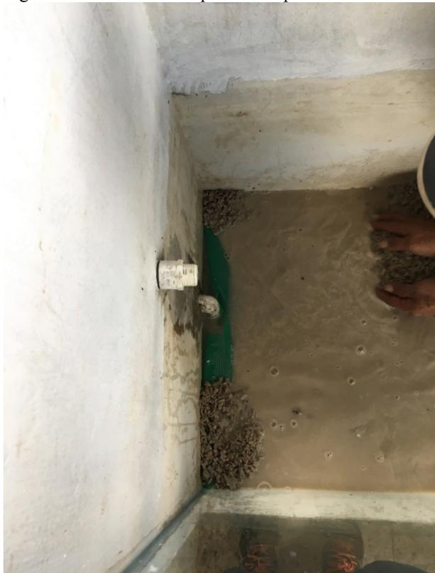
Figura 21. Colocacion de malla en salida de agua del humedal
