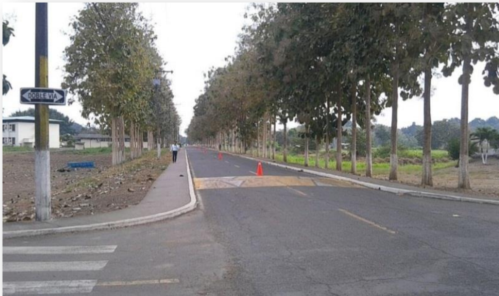
Ilustración 30 Vía Interna de la Base Taura Fuente. Complejo Base Taura. Elaborado por: Vásquez Pardo, Juan
