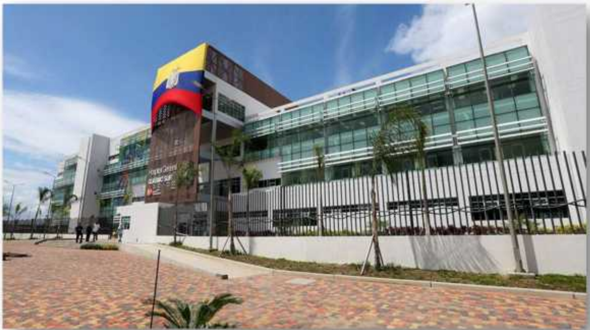
Imagen 7. Hospital General del Guasmo Sur Guayaquil.
