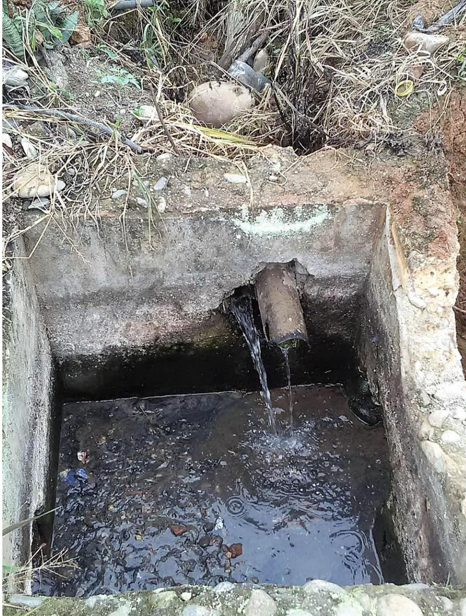
**Ilustración 28. Fuga de agua en tubería.**
