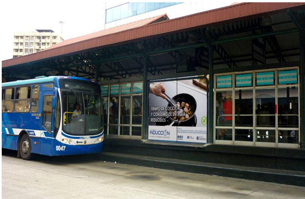
Figura 21 Puerta doble exterior Elaborado por: Autor
