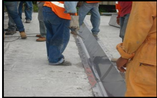
Imagen 24: instalación de canalón Fuente: Roy Briones 2018
