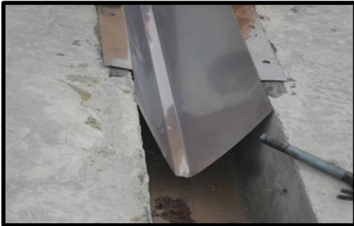
Imagen 23: instalación de canalón. Fuente: Roy Briones 2018
