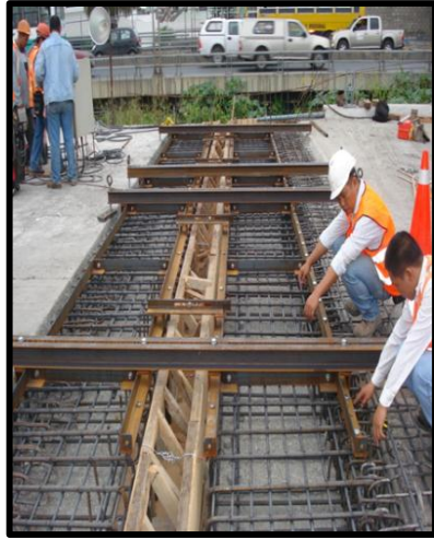
Imagen 3-4: Anclajes pre hormigonado. Fuente: Roy Briones 2018
