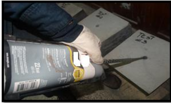
Imagen 58. Inyección de epóxico Fuente: Royy Briones 2018.
