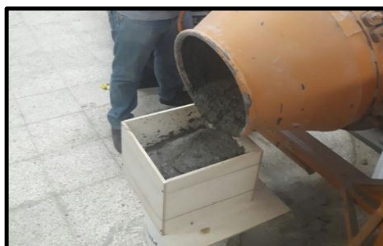
Imagen 48. Vaciado de hormigón en encofrado. Fuente: Royy Briones 2018.
