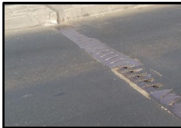
Imagen 12: Juntas de placa dentada tipo sierra.
