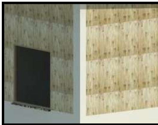
Ilustración 38 Detalle de caña picada en fachada. Elaborado por: Juan González y Juan Cruz
