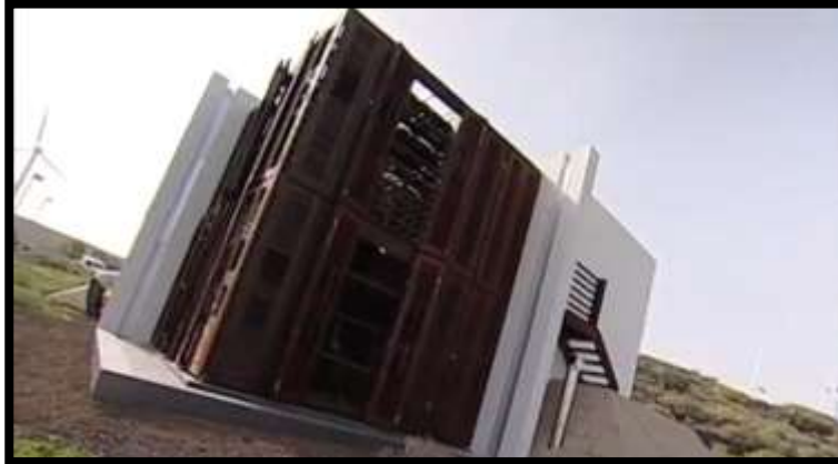
Ilustración 6 Posterior Casa "El Cubo". Fuente: Casas Iter Bioclimáticas.
