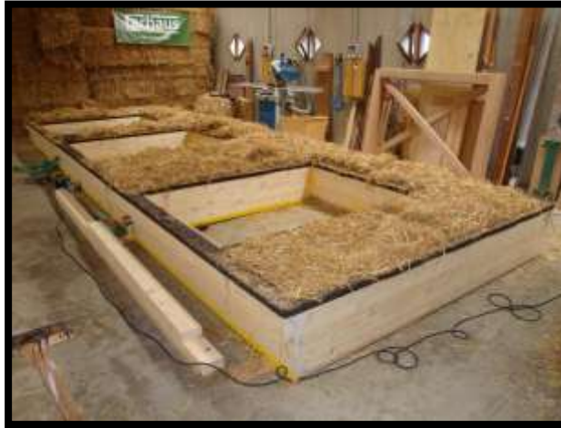
Ilustración 9 Proceso constructivo Larixhaus Fuente: Construction 21, España.
