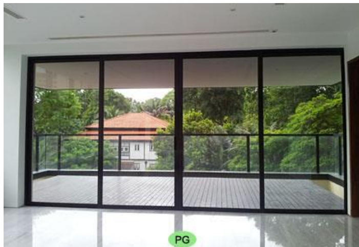
Ilustración 85: Ventanas con vidrio refractario.
