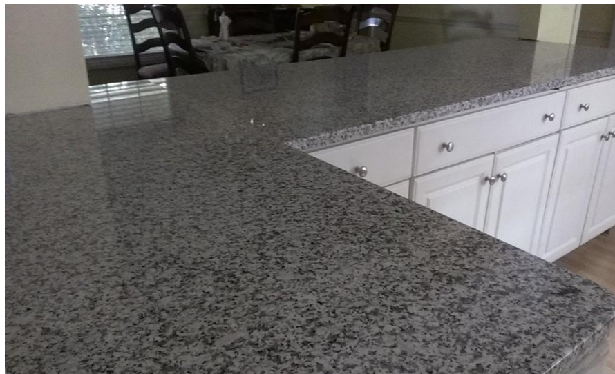
Ilustración 87: Mesón de cocina de granito.
