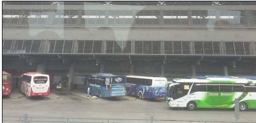
Ilustración 13: Buses Terminal Terrestre de Guayaquil.
