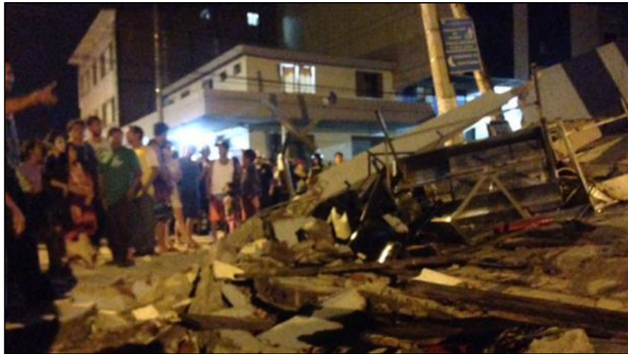
Ilustración 12: Paso a desnivel colapsado debido a sismo del 16 de abril del 2016. Fuente: El Comercio (2016)
