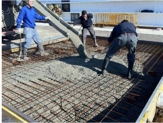
Ilustración 78: Contra piso. Fuente: Google imágenes (2017)
