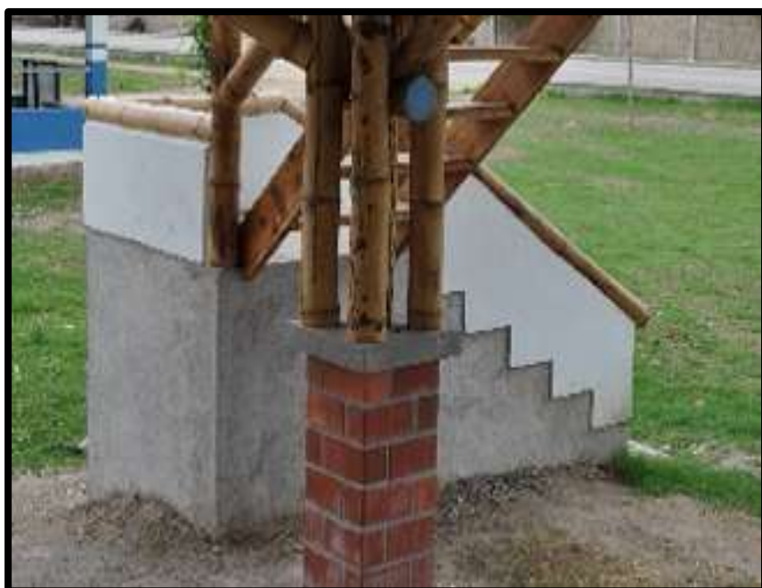
Ilustración 21- Cimientos de vivienda Fuente: La Revista. Vivienda en Olón con caña guadua.
