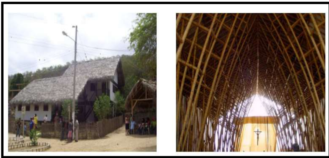
Ilustración 12 - Utilización de caña guadua y paja toquilla
