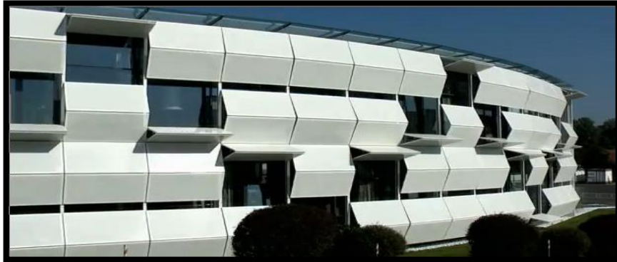
Figura 18 Fachada móvil con PVC
