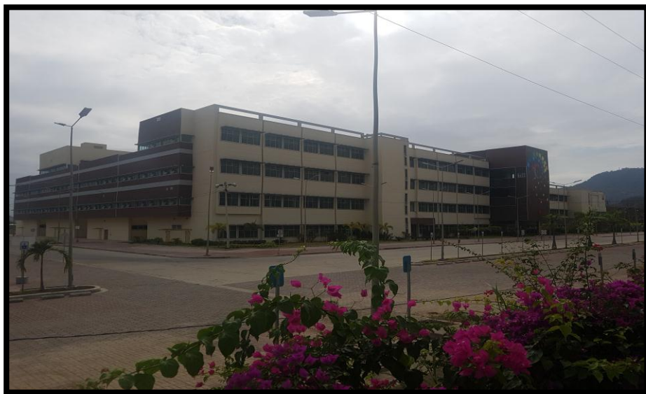
Figura 40 Fachada oeste del Centro Hospitalario Monte Sinaí
