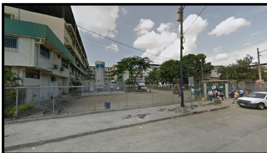
Figura 34 Fachada Oeste del Hospital Teodoro Maldonado Carbo
