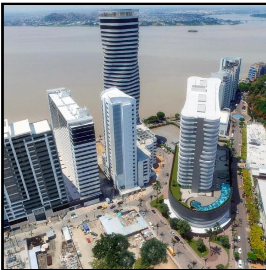
Figura 7 Edificaciones en Guayaquil
