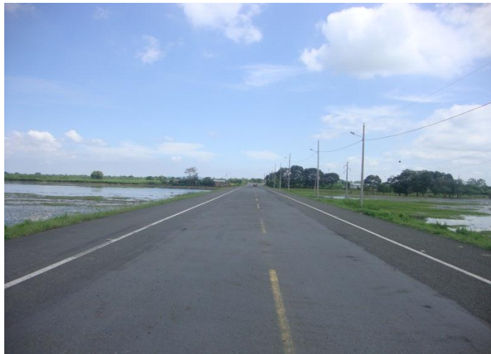
Fotografía 26: Bypass de Baba que une a la vía colectora E 485 Daule T de Baba Fuente: Fotografía realizada por el autor.
