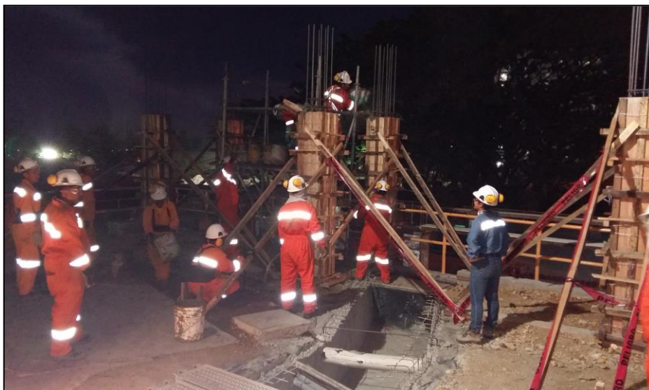
Figura 5: Fundición de columnas de hormigón armado
