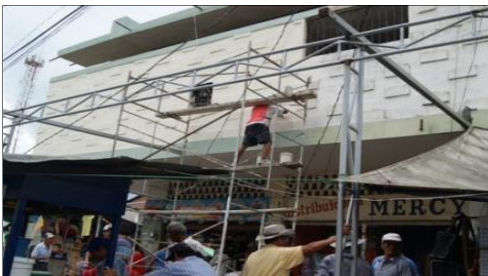
Figura 4: Mantenimiento de pintura del mercado central “Calceta”.
