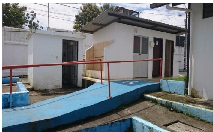
Figura 31. Servicios Higiénicos y Cuarto de bomba.
