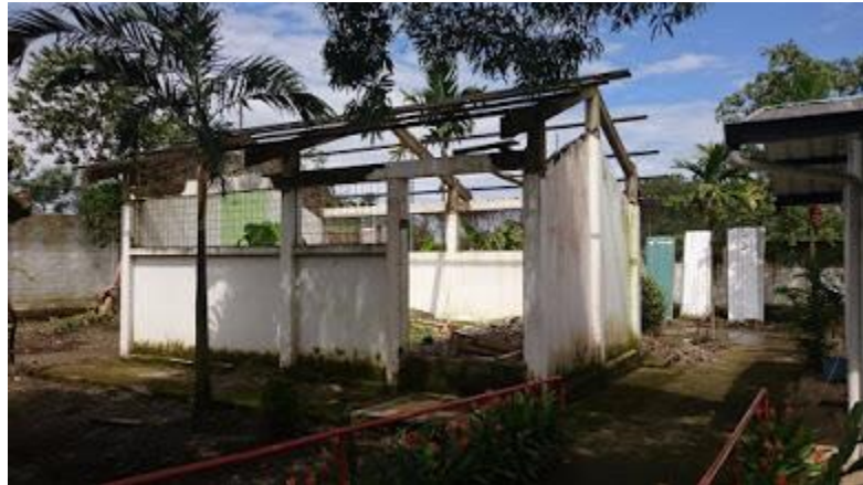
Estructura Actual de la iglesia
