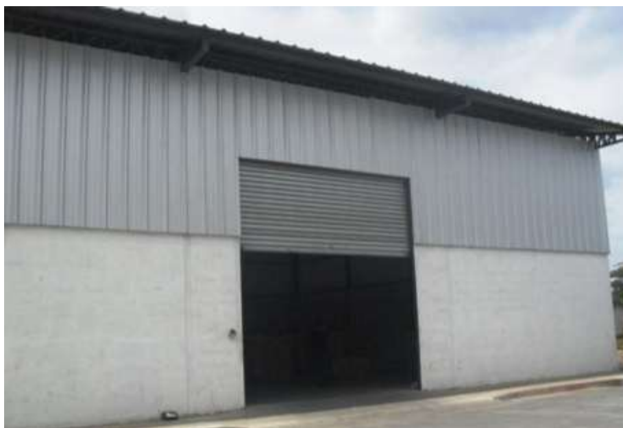
Figura 1. Detalle fotográfico de instalaciones del galpón Fuente: Carlos Camacho
