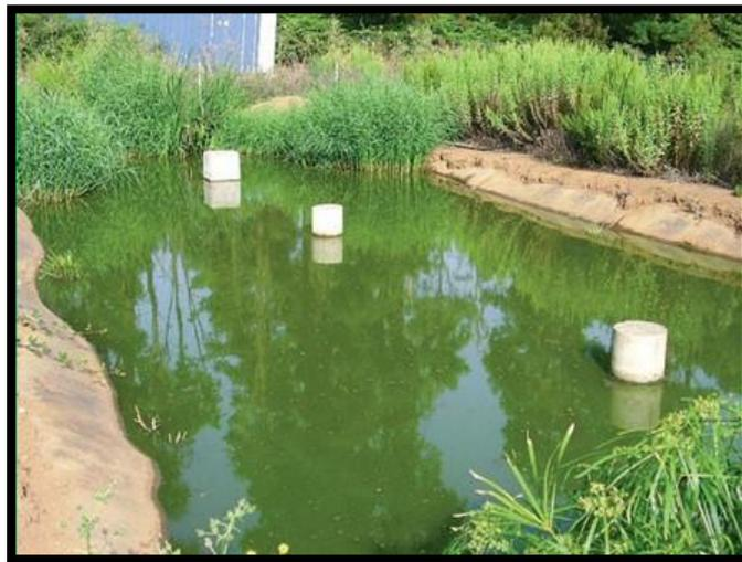
**Figura No. 10** Estanques de depuración.
