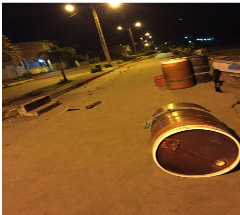
Figura 6. Malecón en mal estado
