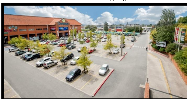
Figura 27 Portones Shopping Estacionamiento
