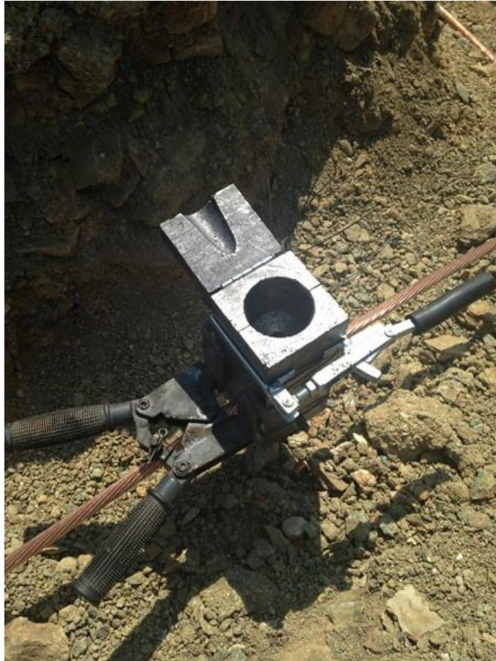
*Foto 10. Conector de Cable a Tierra con el Electrodo Mediante Fundición.*
