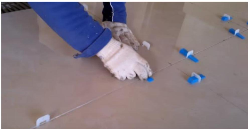
*Foto 20.* Uso de Separadores para una Correcta Alineación de las Placas de Cerámica.
