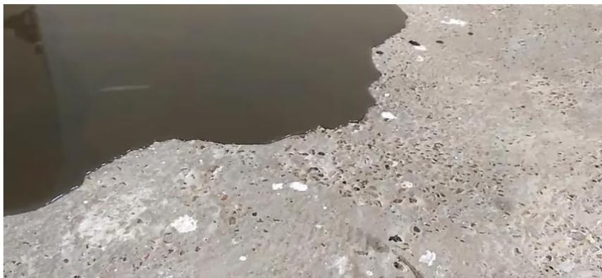
*Foto 18. Uso de Mortero Autonivelante Sobre el Contrapiso.*
