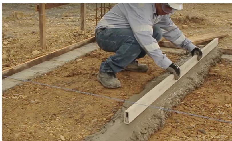
*Foto 15.* Nivelado de la Mezcla Durante la Fundición.
