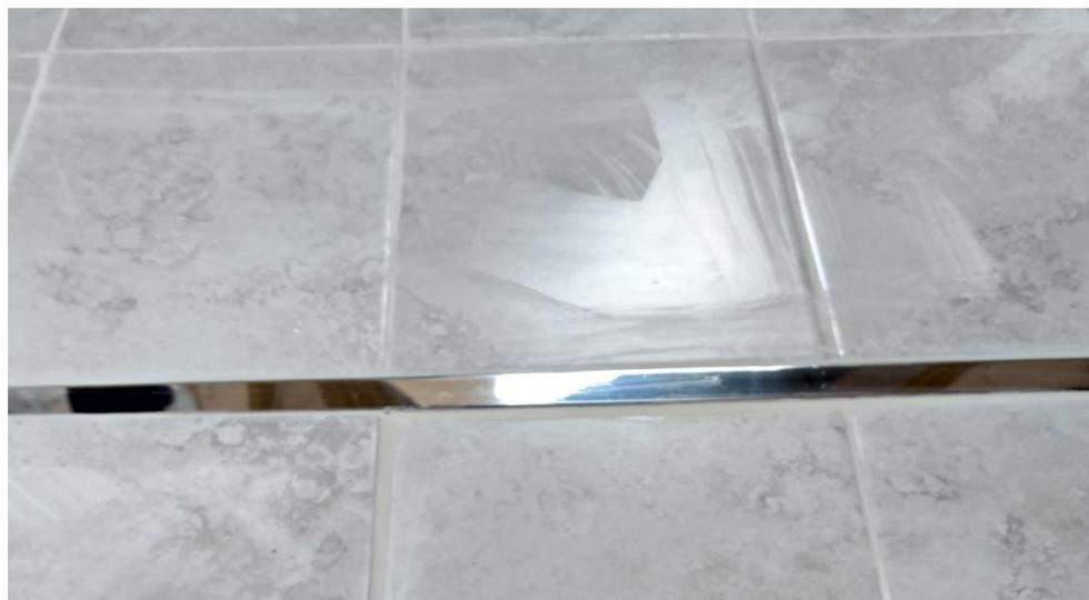
*Foto 26.* Emporado en las Juntas de las Placas del Piso.
