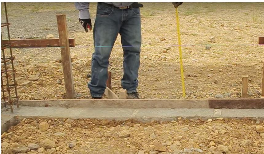
*Foto 12.* Referenciando las Cotas del Contrapiso y Colocación de Guías.
