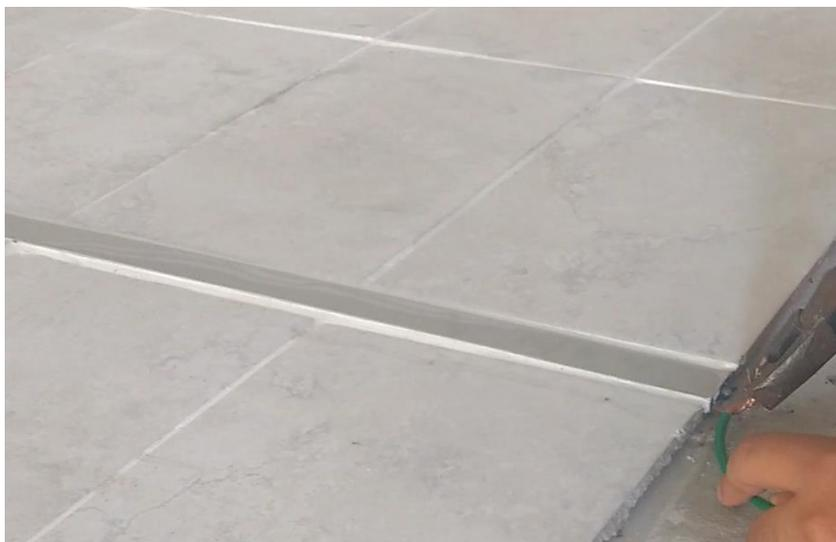
*Foto 5. Conexión del Perfil Metálico a Tierra Lateral.*
