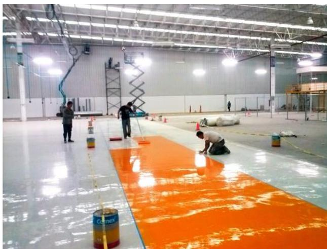
*Ilustración 5. Pintura epóxica*
