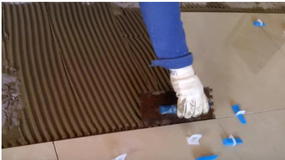
*Foto 19.* Uso de la Llana Dentada para la Colocación del Mortero en Forma Horizontal.
