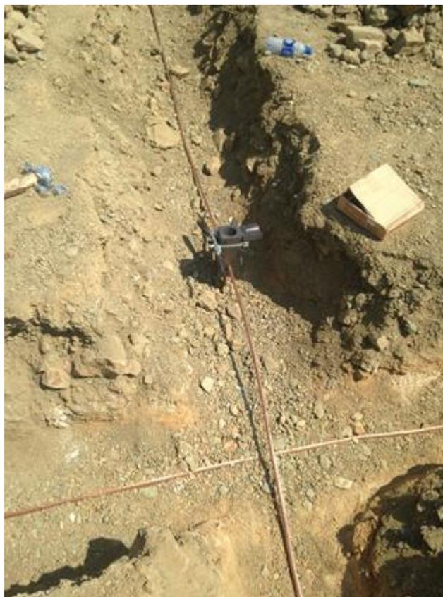
*Foto 11.* Malla de Puesta a Tierra Conectando las Varillas de Cobre en Paralelo.
