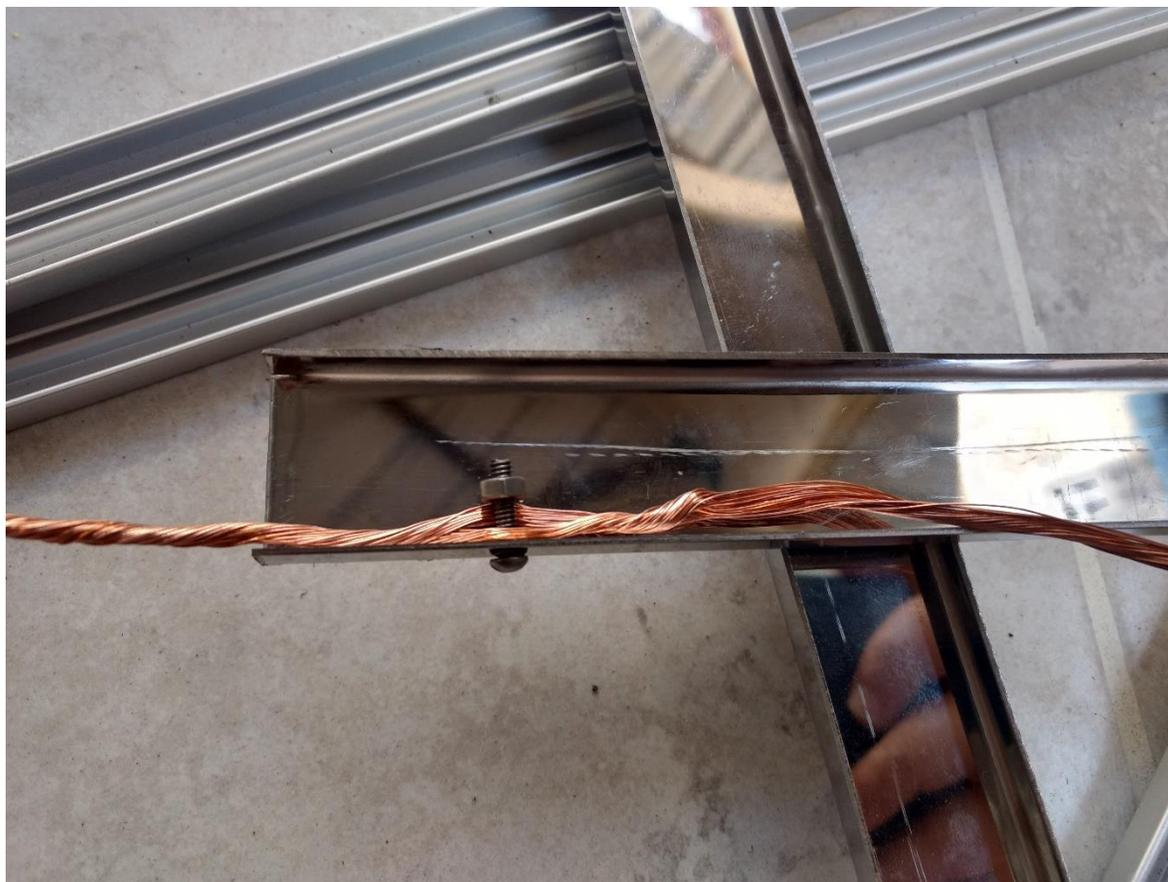
*Foto 21.* Unión de Conductor de Cobre al Perfil a través de un Perno de Sujeción.
