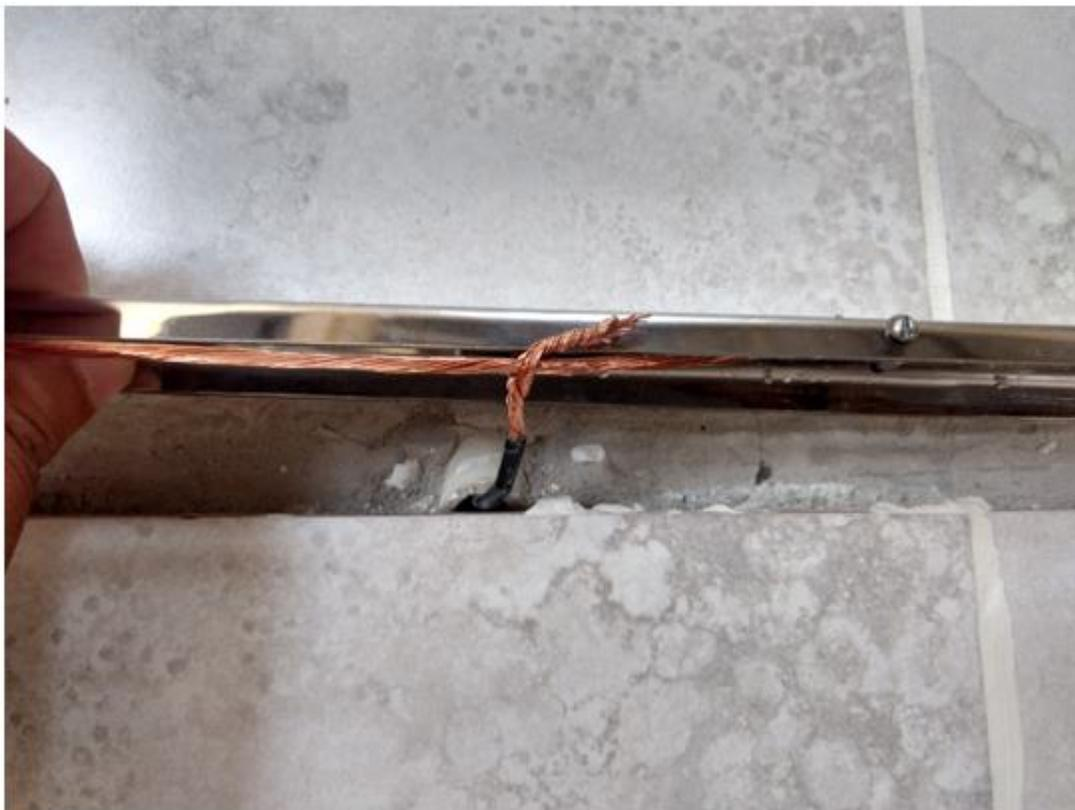
*Foto 23.* Conexión del Perfil de Acero Inoxidable a la Puesta en Tierra Previamente Conectada.
