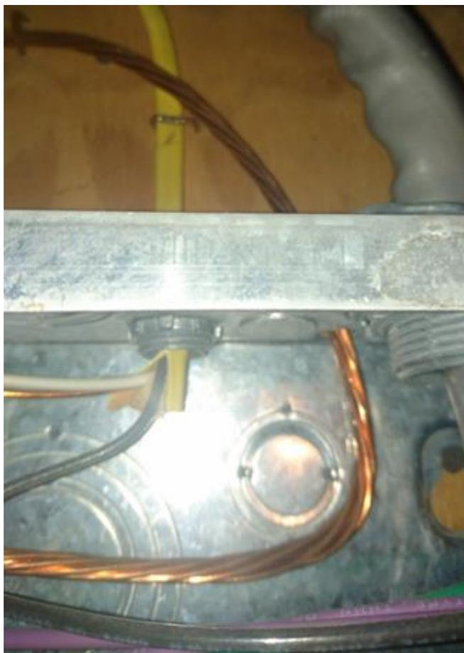
*Foto 9. Conductor a Tierra a través del Panel Principal de Breakers.*
