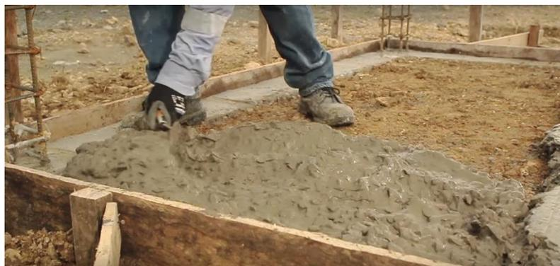
*Foto 14.* Fundición del Contrapiso.
