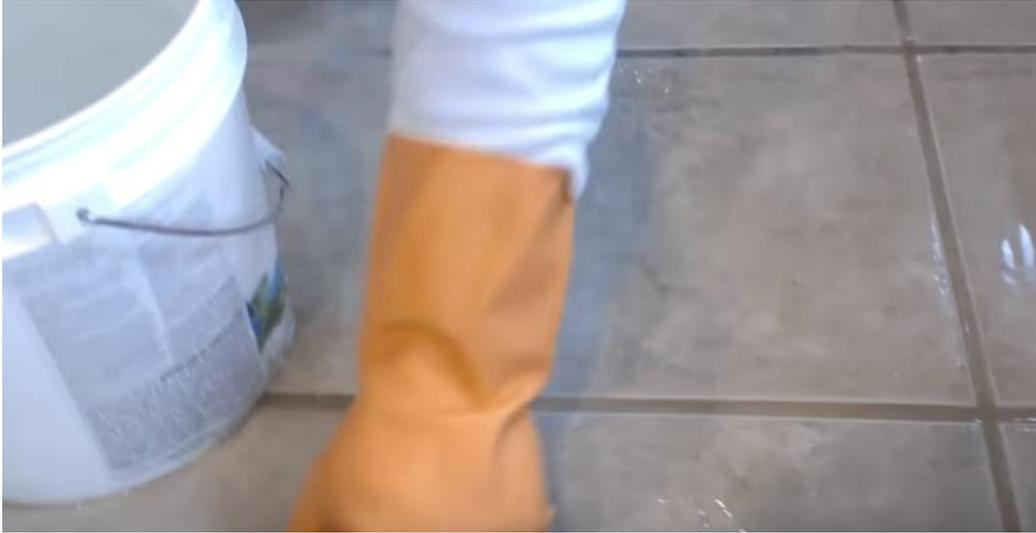
*Foto 27.* Limpieza del Exceso de Emporado en las Juntas de las Placas del Piso.
