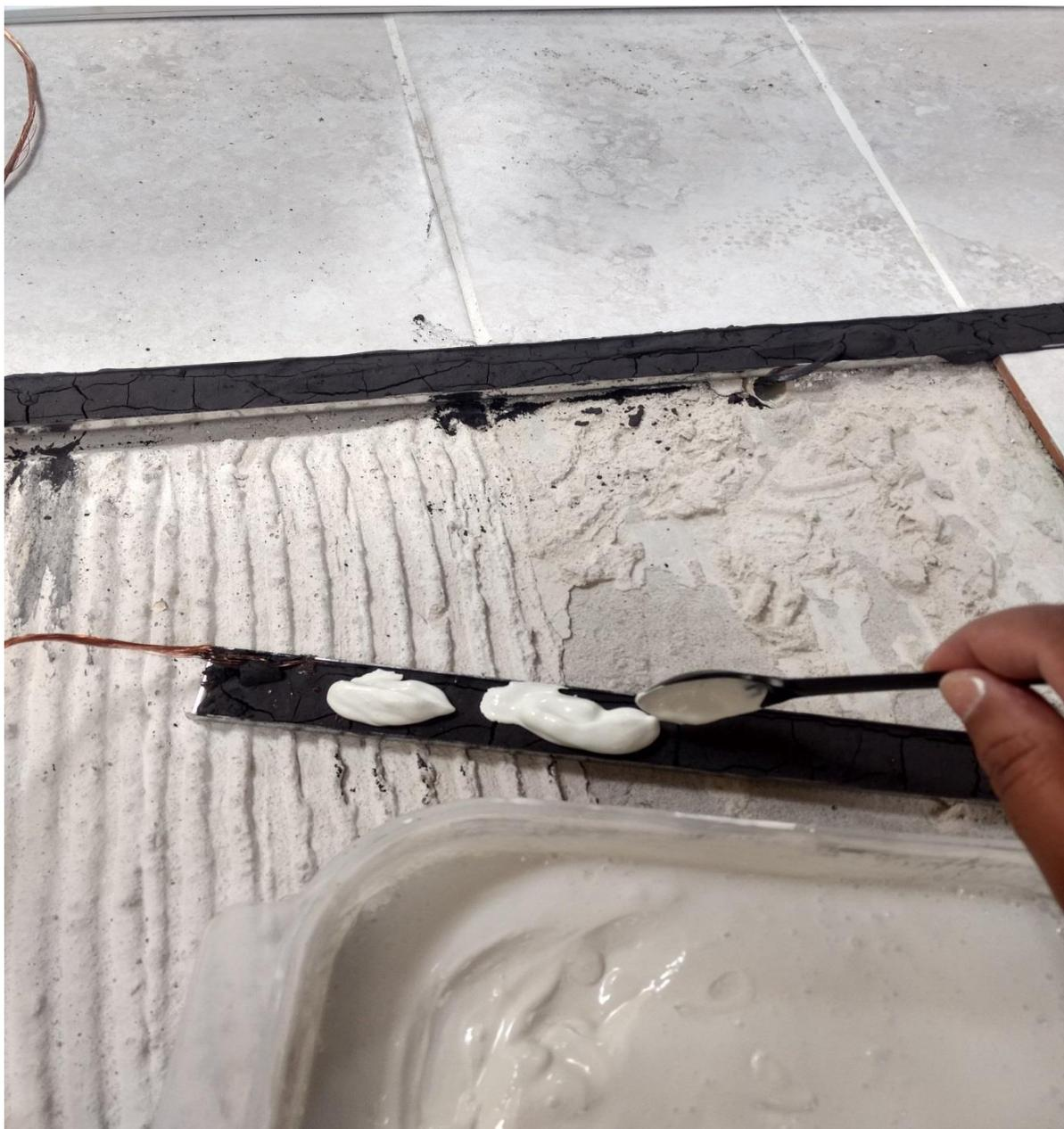
*Foto 25. Colocación del Empore Sobre el Grafito Previo a su Colocación en el Contrapiso.*
