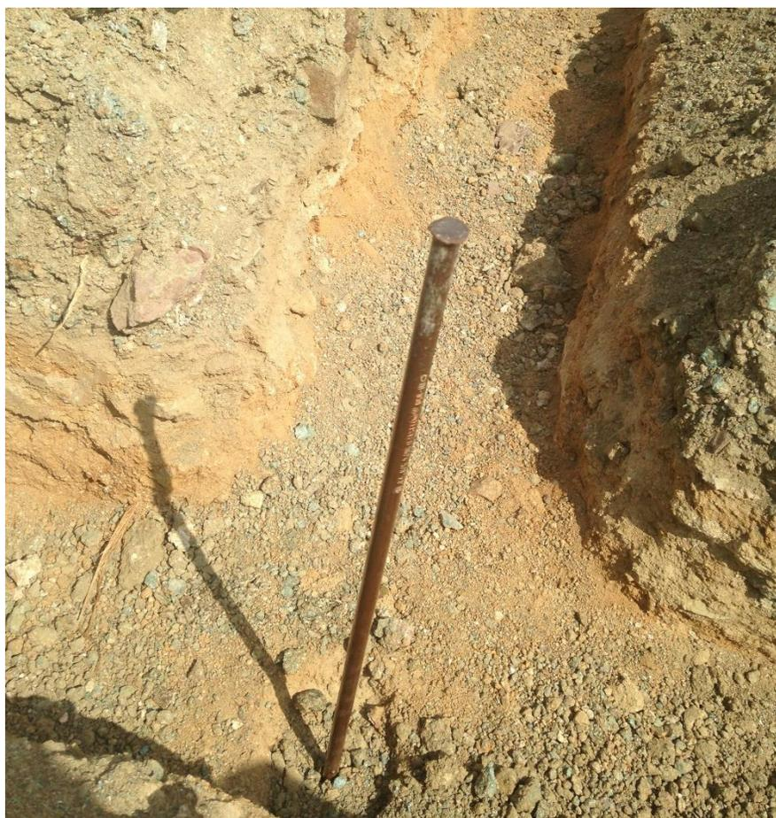
*Foto 8.* Varilla de Cobre Enterrada a 6 Pies de Profundidad.
