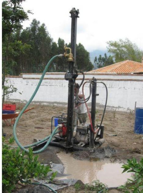
Para la perforación del Pozo se necesita una máquina (adj. Foto) la cual en la elaboración del mismo se demora en un tiempo de 8 a 15 días dependiendo del tipo de suelo.
