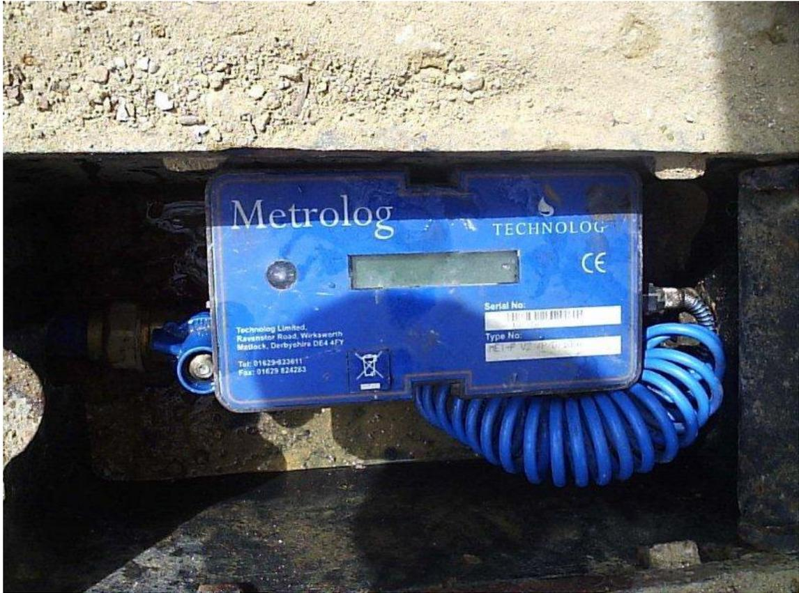
**Figura 17. Instalación de Metrolog en cajetín de medidor.
