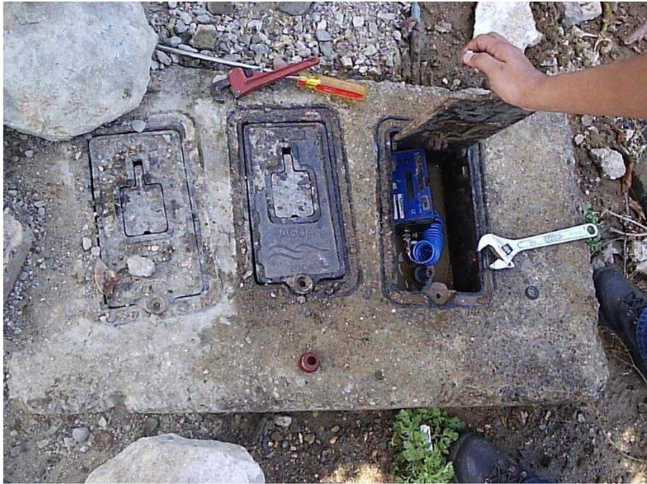
**Figura 15. Chequeo del funcionamiento del Metrolog.**
