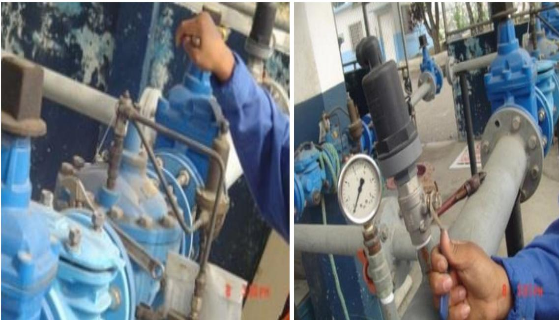
**Figura 33. Mantenimiento rutinario verificación de VRP y ventosa.
