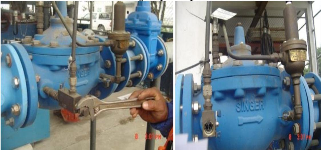
**Figura 36. Mantenimiento integral preventivo de piloto.
