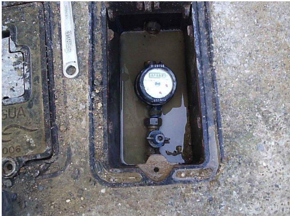
**Figura 20. Toma de presión manométrica en campo con desmontaje de medidor.
