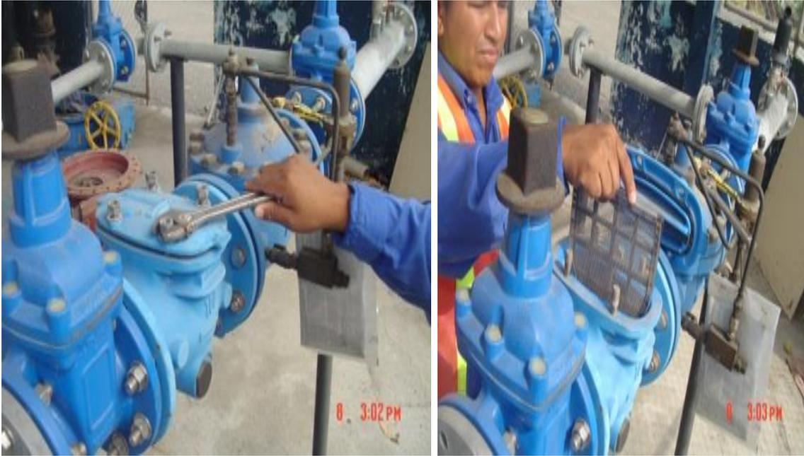
**Figura 34. Mantenimiento rutinario verificación de filtro.
