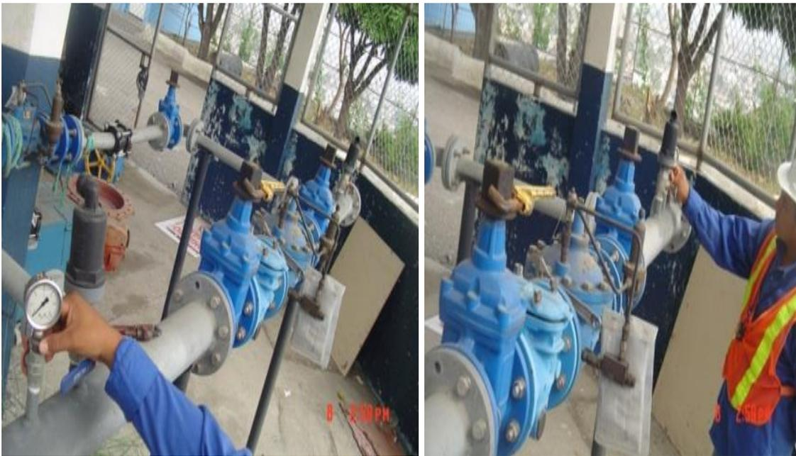
**Figura 31. Mantenimiento rutinario toma de presión.
