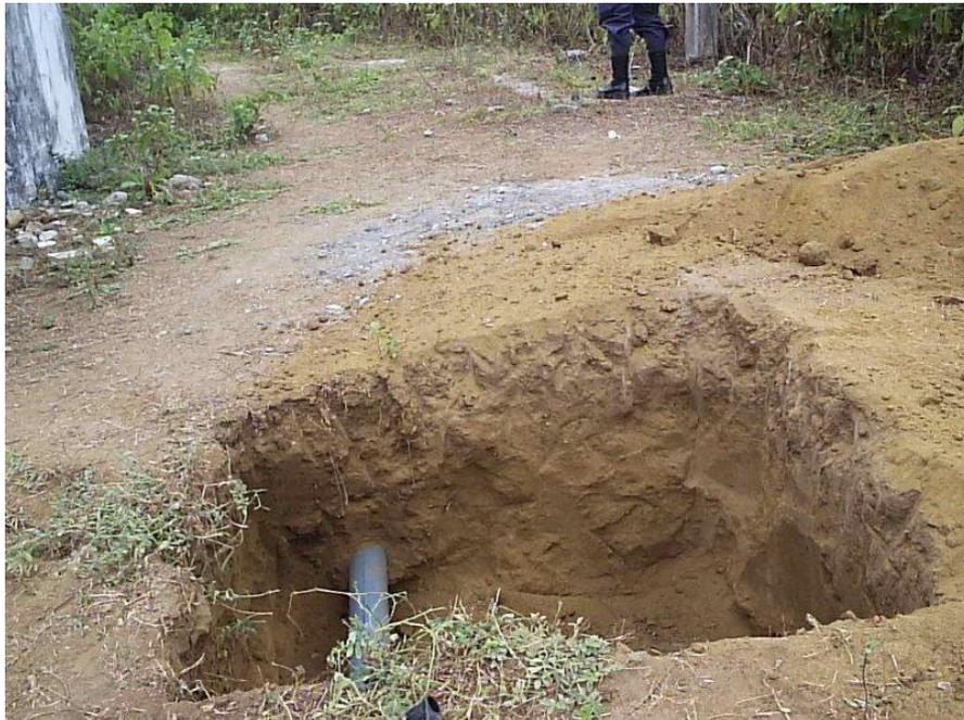
**Figura 6. Sondeo para instalación de caudalímetro portátil ultrasónico SIEMENS.
