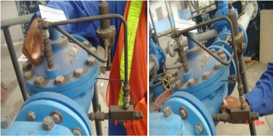
**Figura 35. Mantenimiento integral preventivo VRP y sus elementos.
