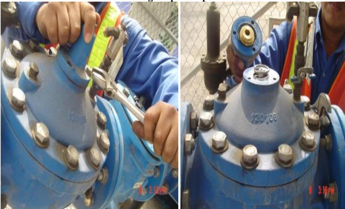
**Figura 38. Mantenimiento integral preventivo elementos internos.
