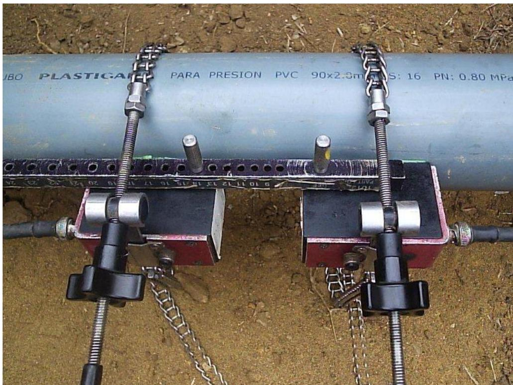
**Figura 8. Instalación del sensor para el caudalímetro portátil ultrasónico SIEMENS.**
