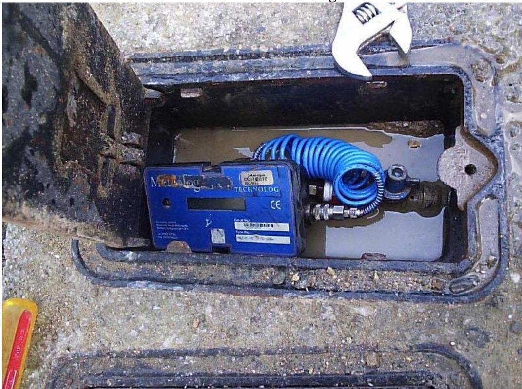
**Figura 14. Ejemplo uso del Metrolog para controlar presión del sector.
