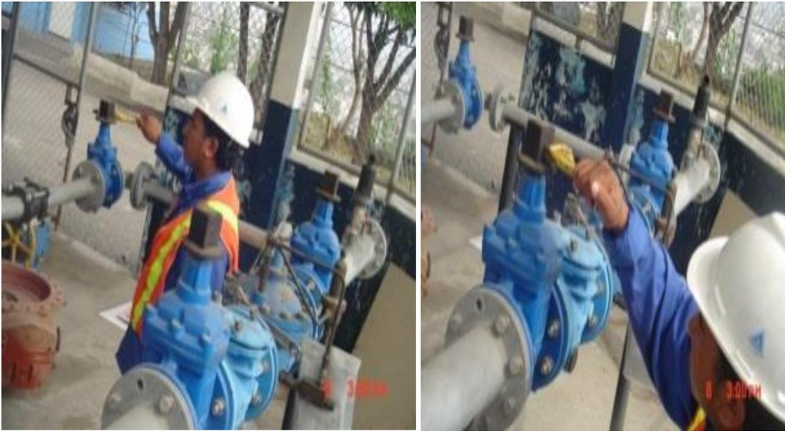
**Figura 32. Mantenimiento rutinario verificación de estado de válvulas.
