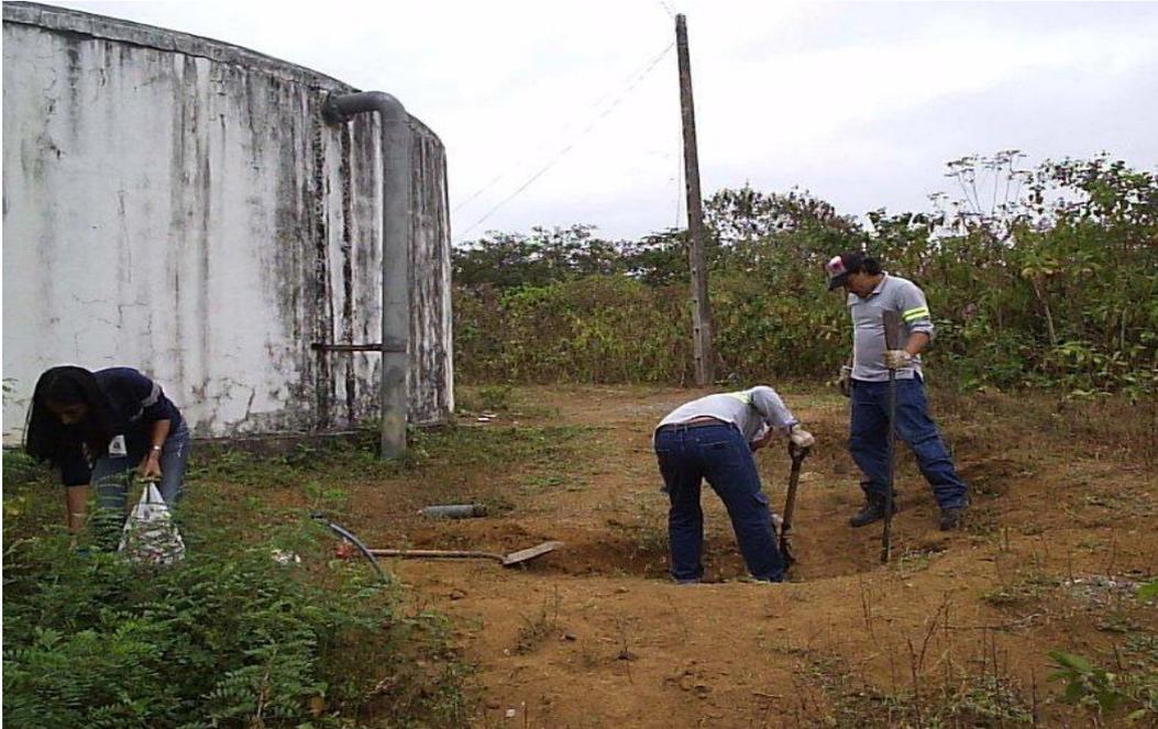
**Figura 5. Sondeo para instalación de caudalímetro portátil ultrasónico SIEMENS.
