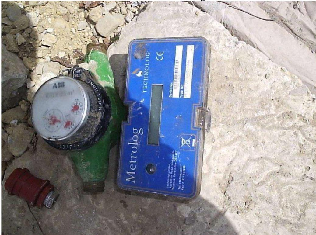
**Figura 16. Instalación de Metrolog y desmontaje de medidor para ubicación dentro del cajetín.**
