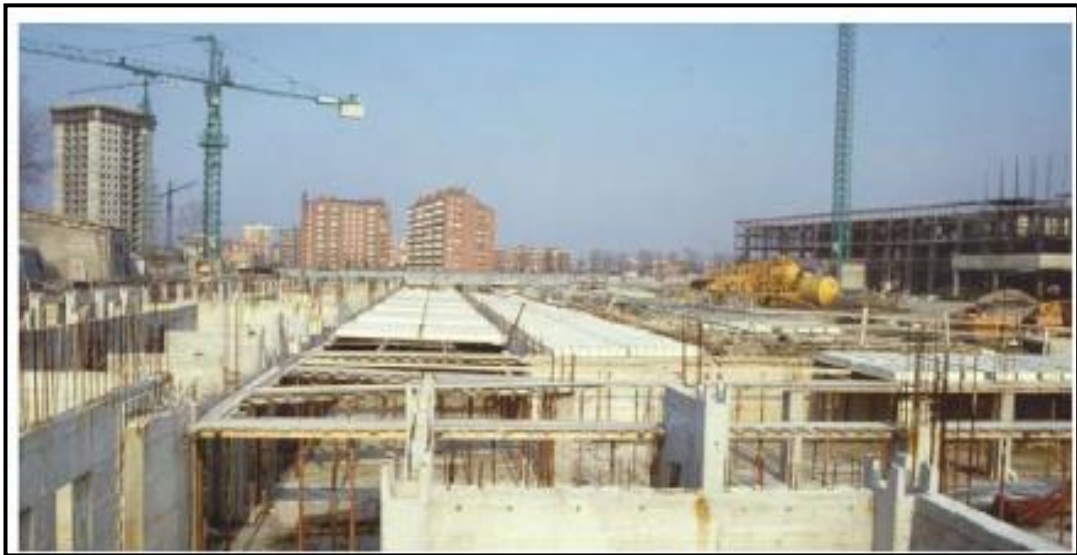
Figura 9. Estructura portante de tabiques de hormigón armado vertido en obra con casetones de multilaminado.
