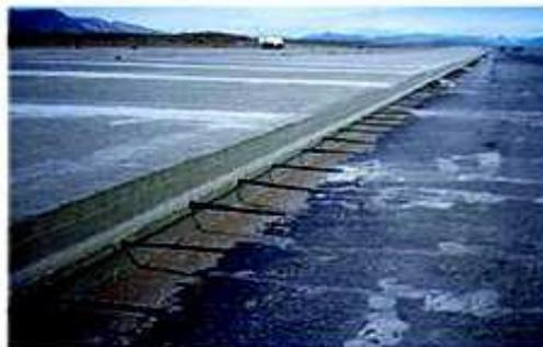
Imagen N° 63 fotografía de barras de unión longitudinal en una vía.
